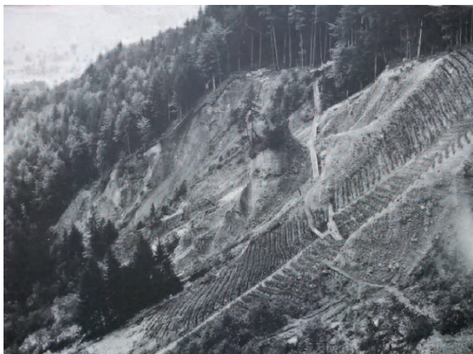
Abb. 2 und 3: Buochserrübi. 1934 (links): Hangstabilisierung mittels Flechtwerk und systematischer Wasserableitung (rechts der Bildmitte mit Rollbahn); 1975 (rechts): junger Mischwald im Aufwuchs.
