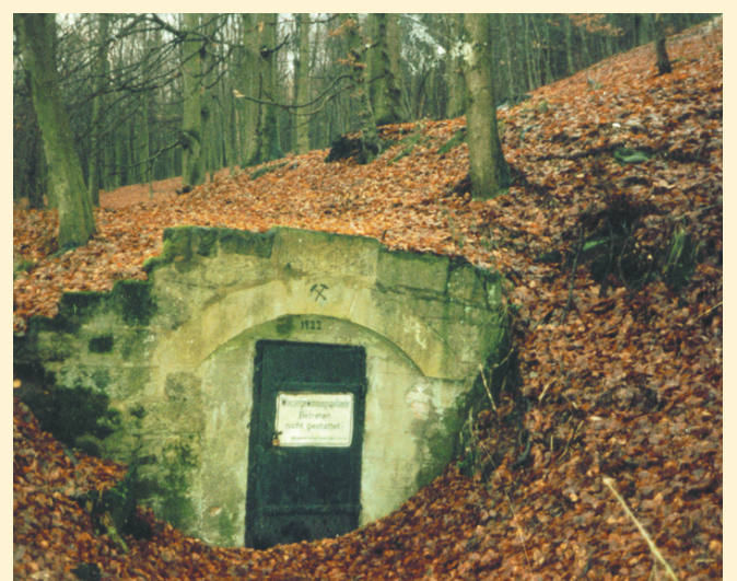
„Mundloch“ des Sammannstollen am Forellenteich.
