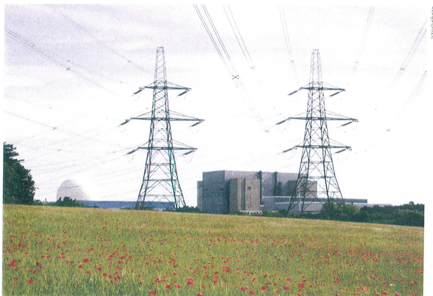
Bild 1 Hinsichtlich der Kernenergie besteht in Grossbritannien weitgehend politische Einigkeit. Im Bild: Kernkraftwerk Sizewell an der englischen Ostküste. Die Anlage A (rechts) wurde 2006 stillgelegt, der Druckwasserreaktor in Anlage B (links) ist noch in Betrieb.
