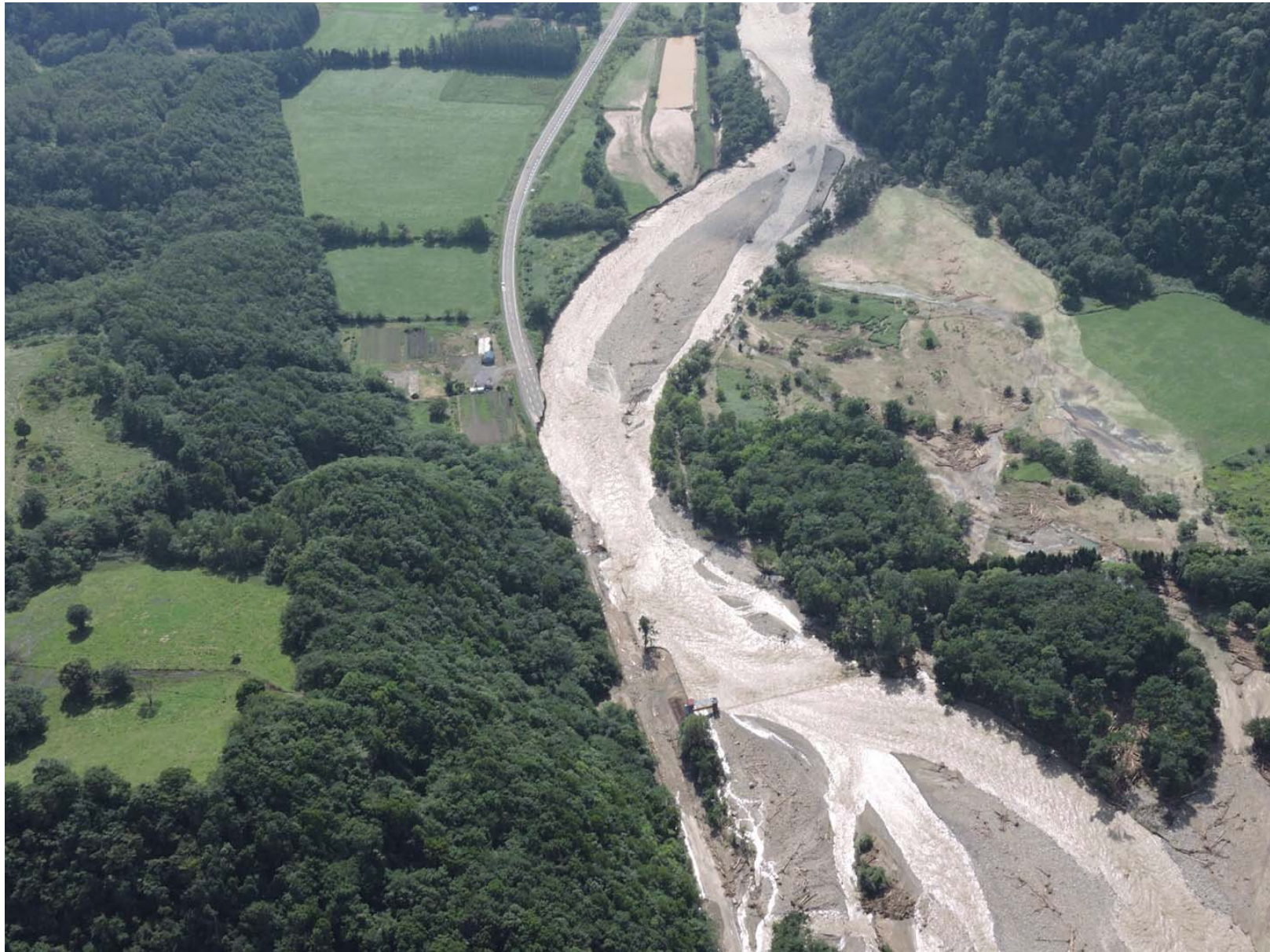
国道274号 日高町千栄 (H28.9.1の状況)
