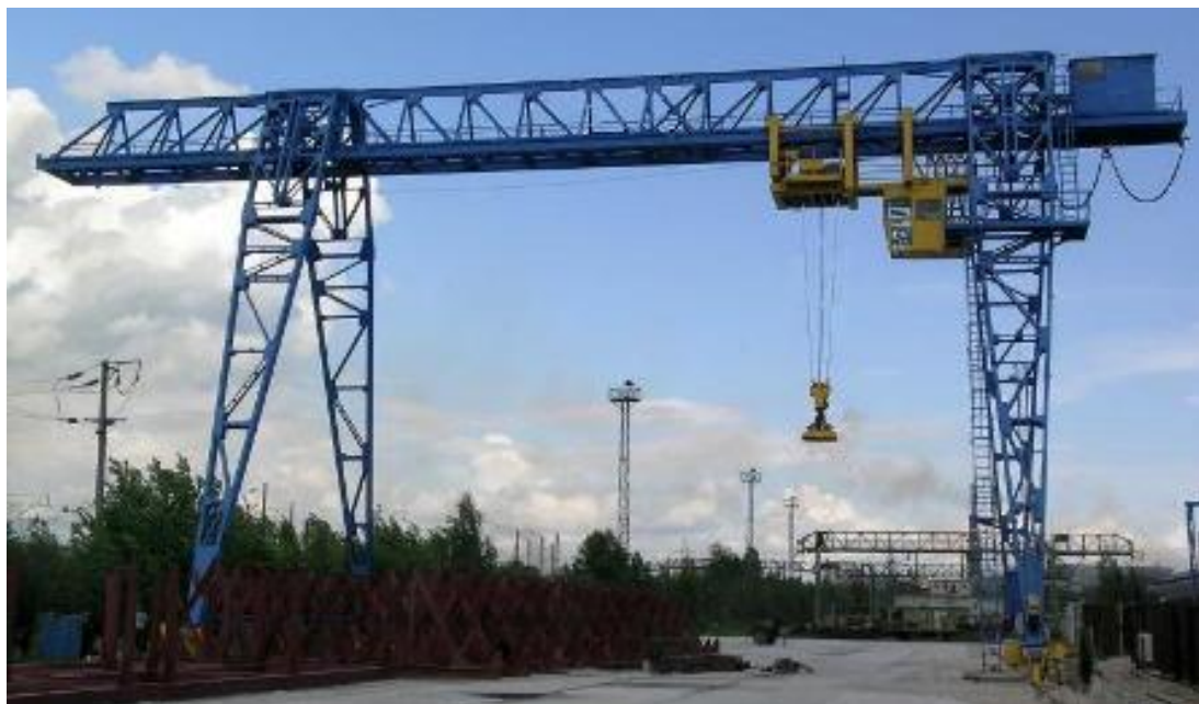
Кран с грузоподъемным электромагнитом
