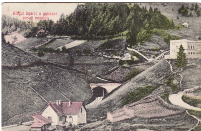
A gyimesi vasút vonal egy alagút torkolatánál (Korabeli képeslap)
