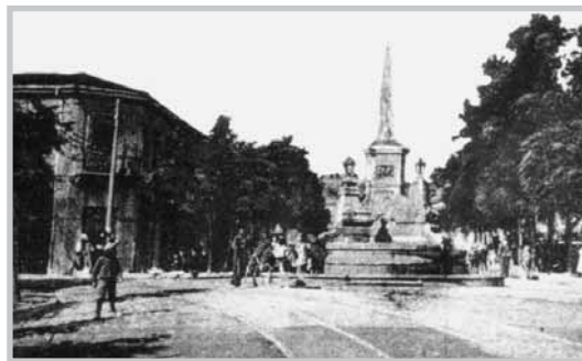
Το κτίριο της Γενικής Ασφάλειας πρώην Καταδίωξης στην Πλατεία Σιντριβανίου πρώην Καλαμαριάς στην αρχή του 20 ου αιώνα.
