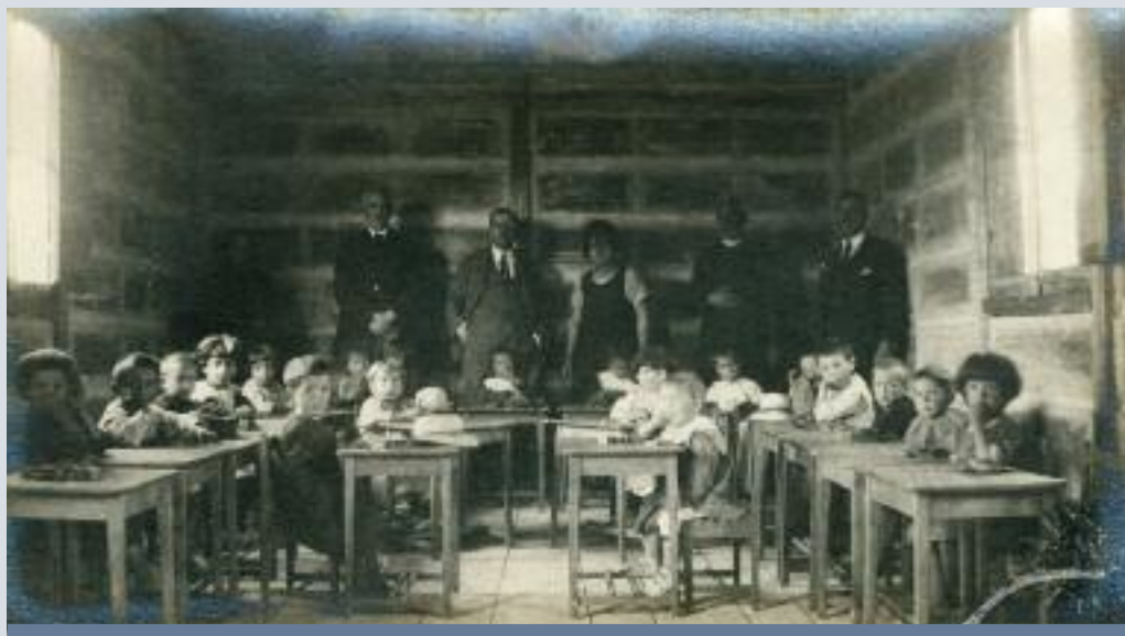
La nuova scuola elementare
