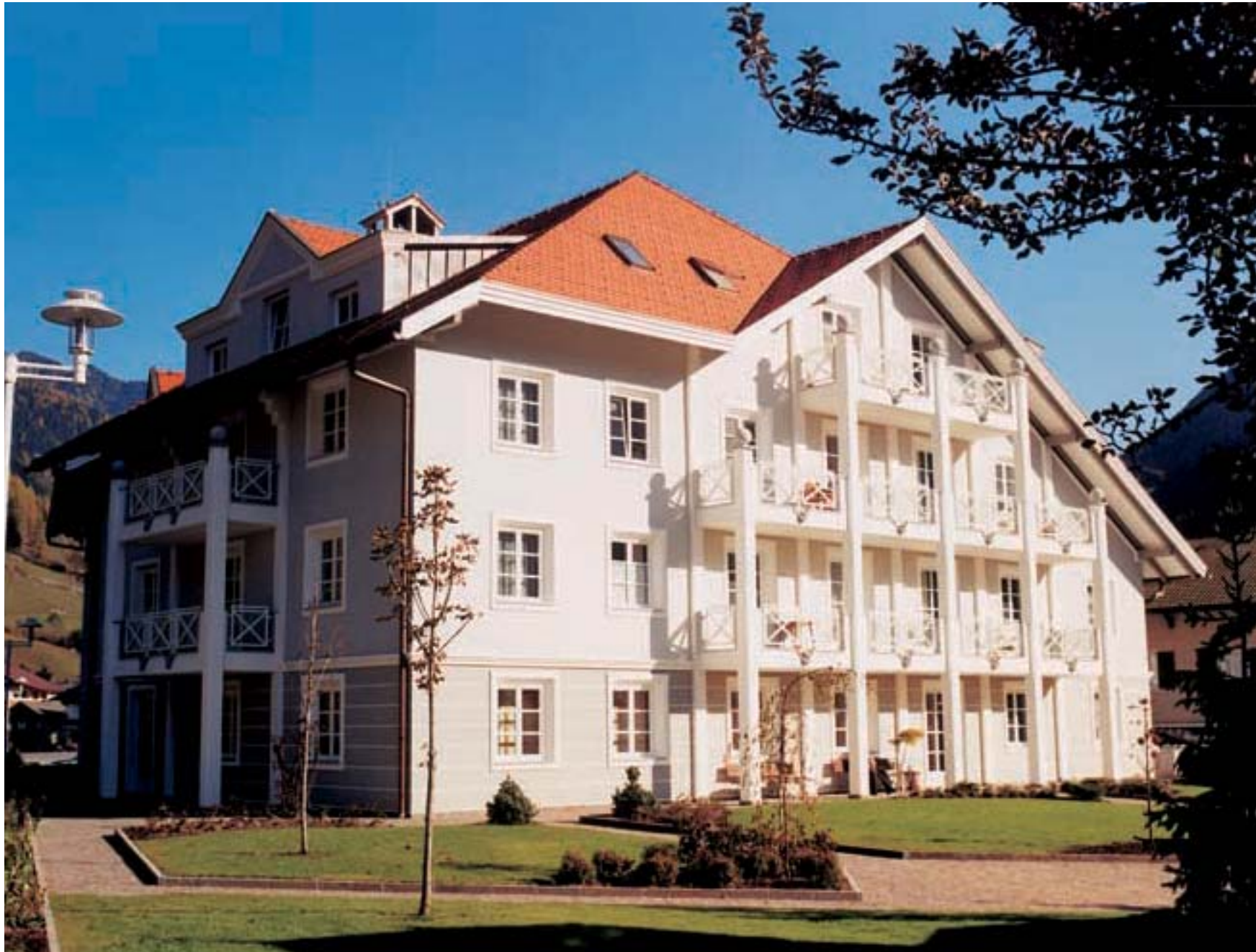
Altersheim Georgianum in St. Johann nach dem Umbau
