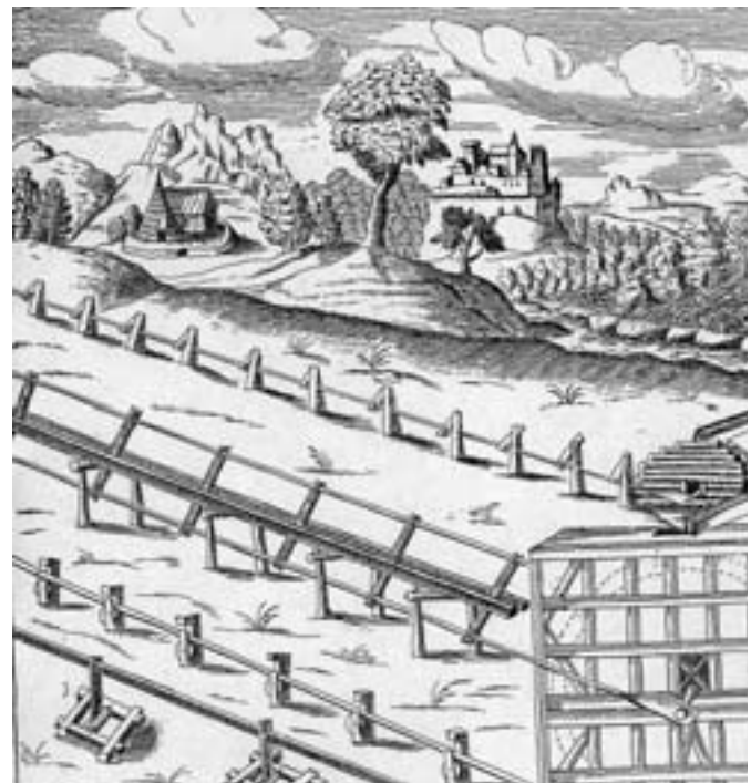
Kraftübertragung durch Gestänge auf weite Distanz (Feldgestänge)
