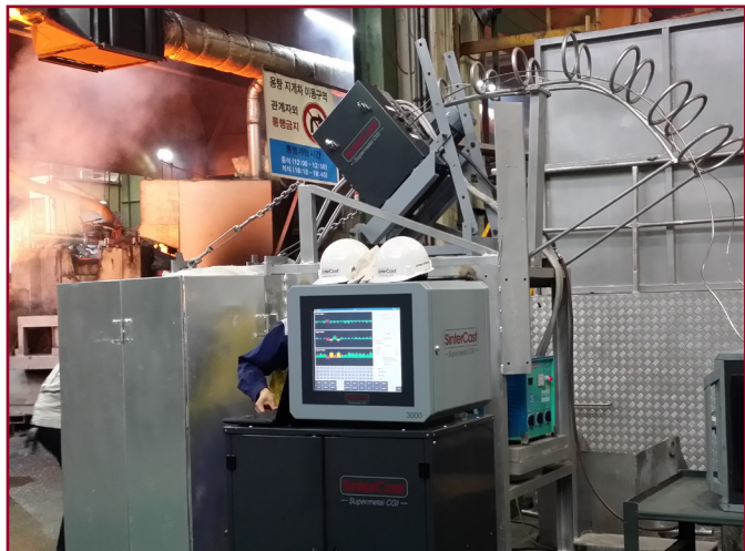
Doosan Infracore, Korea, installerade sitt andra Mini-System 3000 under 2015 för att producera en ny motor för industriell kraft på 27 liter (med tillstånd av Doosan Infracore)
