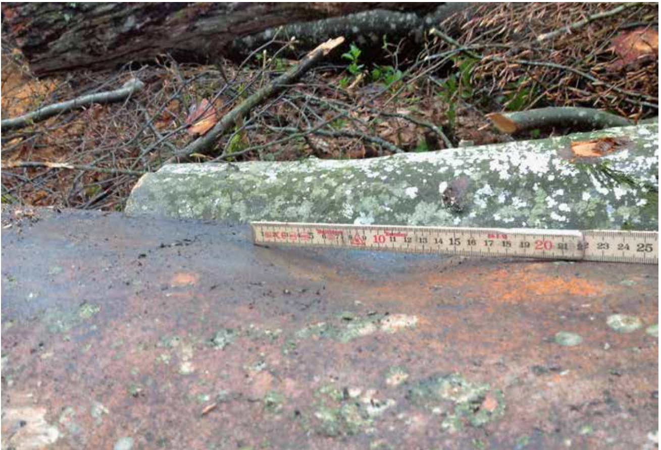
Wurfholz hat Dellen in die Leitungen geschlagen.
