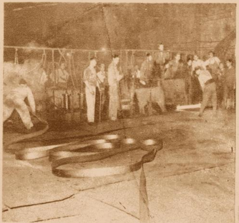
LAMINACION DE HIERROS EN CALIENTE. Se puede observar un fleje que ha pasado por varias máquinas, faltándole tan sólo una, en la cual quedará reducido al espesor deseado, y una palanquilla al rojo que está junto al desbaste, para ser pasada por este cuerpo iniciándose en él su proceso de laminación.
