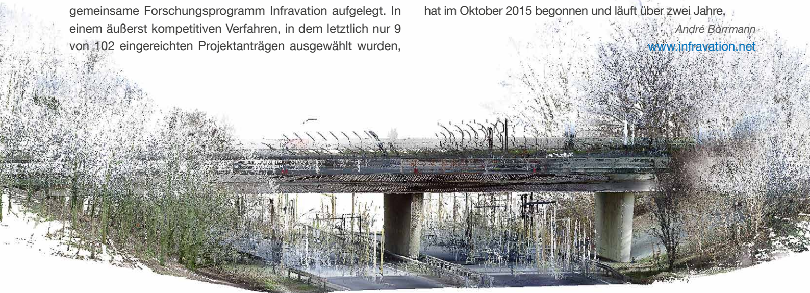
Punktwolke einer Brücke. Punktwolken von Bestandsbrücken lassen sich mittels Laserscanning oder fotogrammetrischen Verfahren erzeugen. Im SEEBridge-Projekt dienen sie als Ausgangspunkt für eine Reihe von Datenverarbeitungsschritten, deren Ergebnis ein semantisch angereichertes 3D-Modell ist. Dieses bildet die Grundlage für die Bewertung des Brückenzustands.
