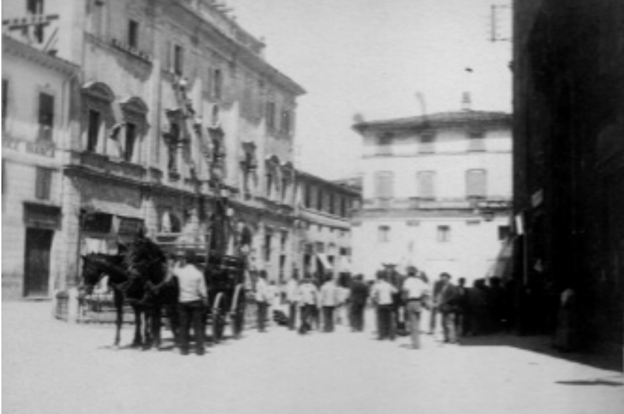
FIG. 2 – RIETI, PALAZZO DEL COMUNE. SOCCORSI SUCCESSIVI AL TERREMOTO DEL 30 GIUGNO 1898.
