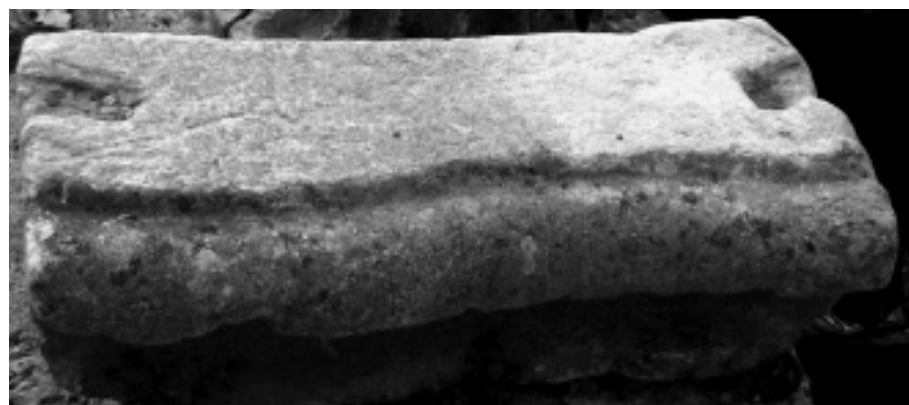
FIG. 3 - BLOCCO IN TRAVERTINO LOCALE DOVE SI POSSONO NOTARE I SEGNI LASCIATI DALL'ALLOGGIAMENTO DELLE GRAPPE DI FERRO (FOTO G. DIONISI).
