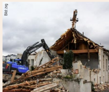
Für den neuen Sakralbau musste die baufällige «Saalkirche» letztes Jahr weichen.
