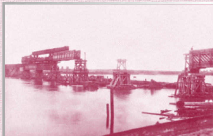
Сооружение временного моста через р. Волхов у ст. Кириши
