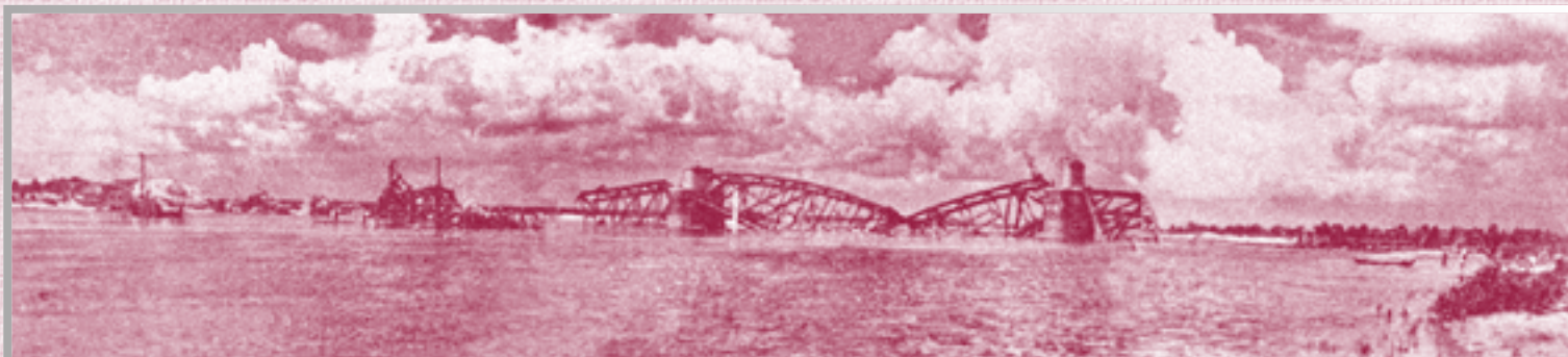
Разрушенный мост через р. Днепр в г. Киеве
