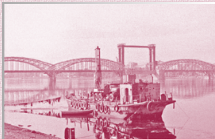
Буровая плавучая установка у Финляндского моста в Санкт-Петербурге
