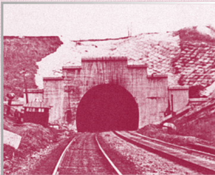
Двухпутный тоннель на линии Львов — Мукачево
