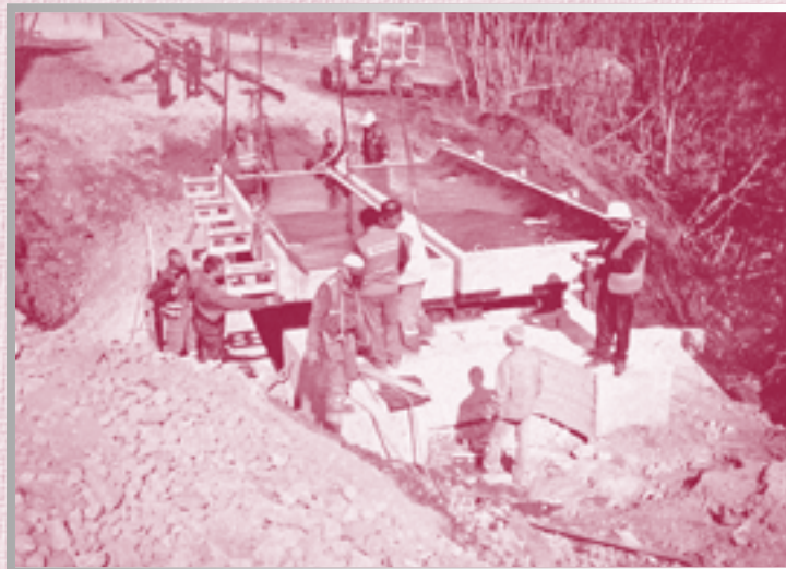
Установка типовых конструкций мостов
