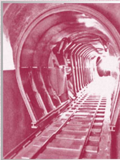
Кружала для реконструкции ж.-д. тоннелей
