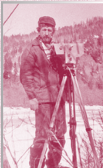
Разбивка опор моста (БАМ)
