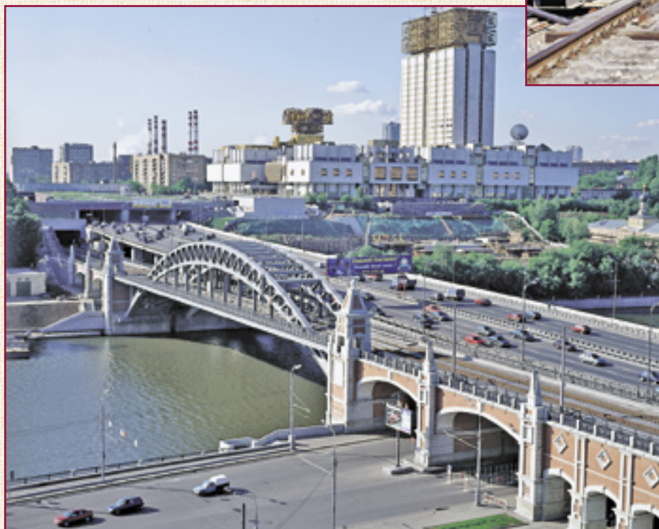
Новый Андреевский железнодорожный мост через реку Москву. Описание на стр. 50
