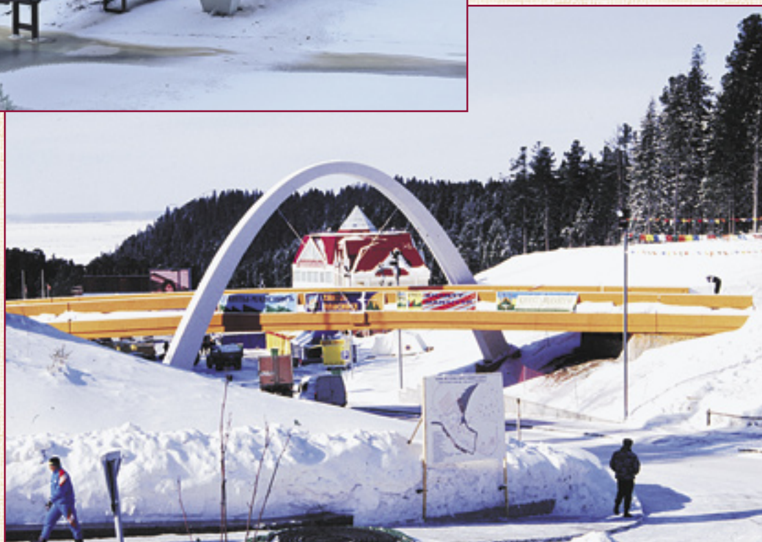
Мост на лыжероллерной трас- се в г. Ханты-Мансийске. Сдан в эксплуатацию в 1997 году. Описание на стр. 55
