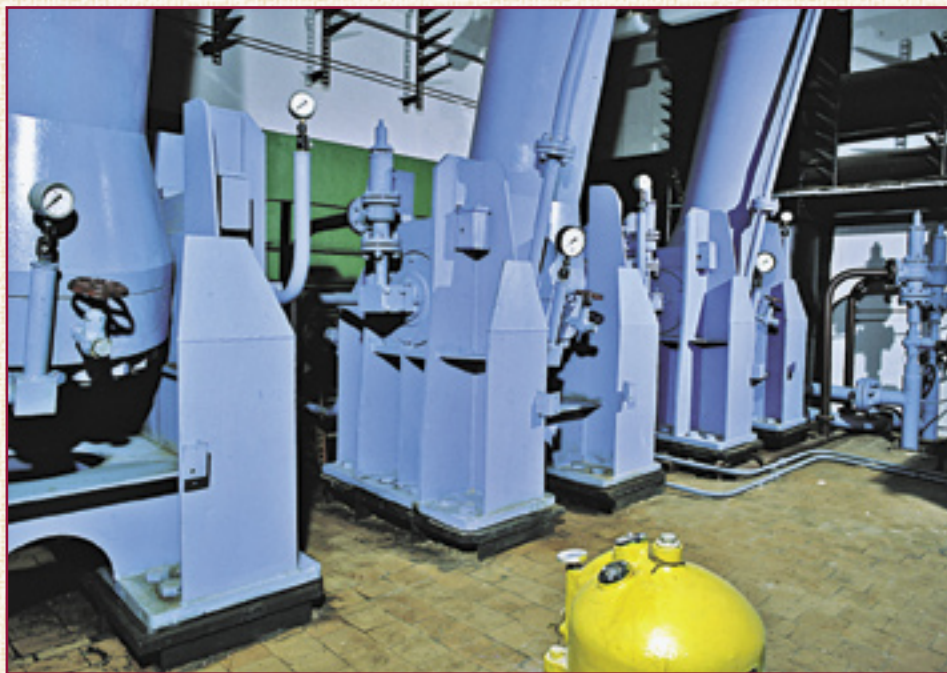
Механизмы и оборудование разводки, изготовленные и смонтированные по проектам Трансмоста для мостов через реку Неву в Санкт-Петербурге
