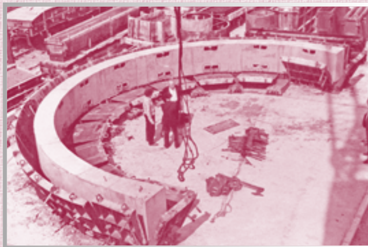
Изготовление тюбингов для сводов реконструируемых тоннелей
