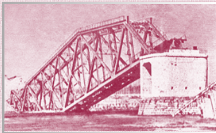
Разрушенный мост через р. Неву у пос. Кузьминки
