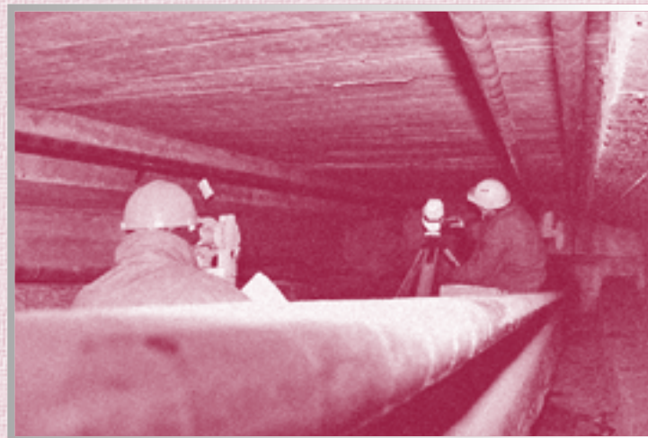
Обследование коробов моста Александра Невского в Санкт-Петербурге. Геодезические работы
