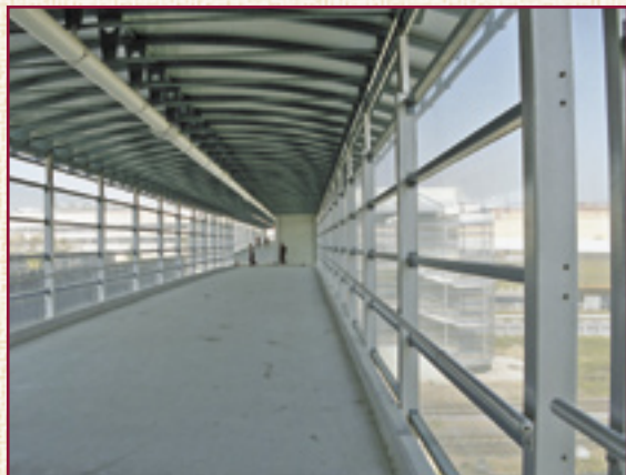
Угрешский пешеходный мост
