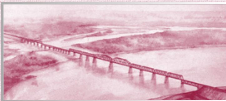
Капитально восстановленный мост через р. Днепр у г. Киева
