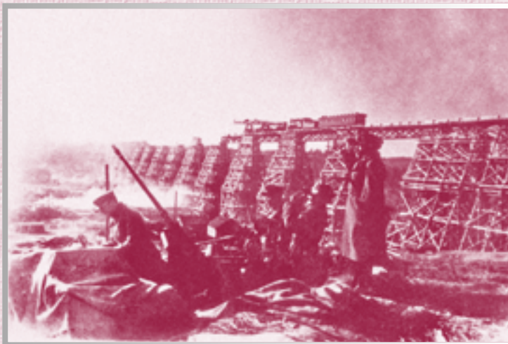
Охрана восстановительных работ
