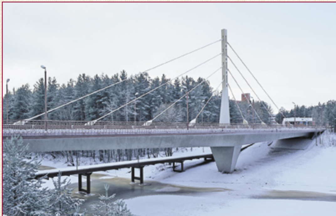
Мост через реку Сестру в г. Сестрорецке. Сдан в эксплуатацию в 1997 году. Описание на стр. 58
