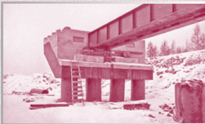
Мост со столбчатыми опорами на центральном участке БАМа
