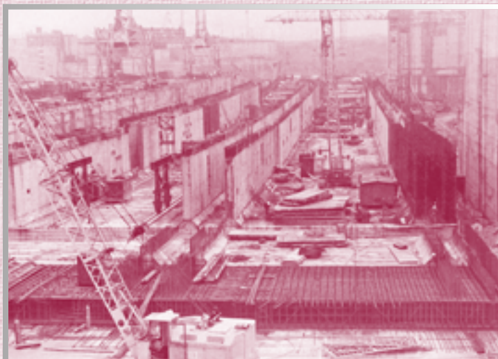
Сооружение подводного тоннеля в составе комплекса защиты Санкт-Петербурга от наводнений
