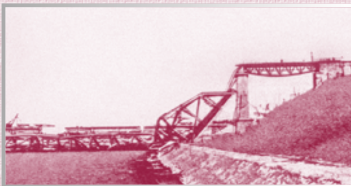
Разрушение берегового участка железнодорожного моста через р. Волхов у г. Волховстроя
