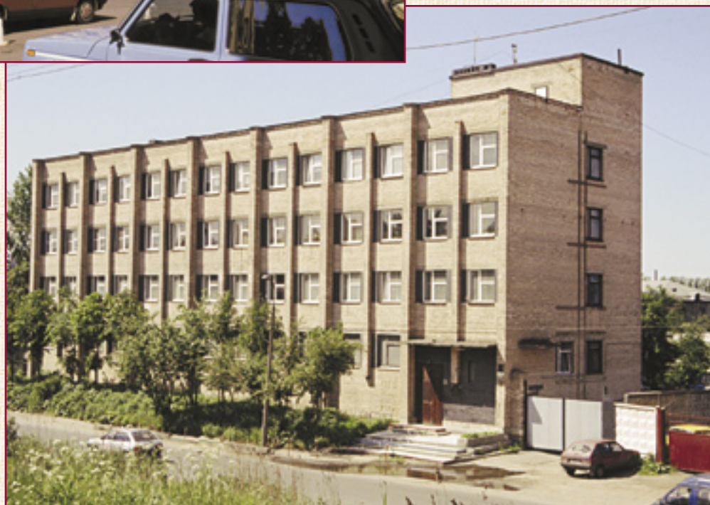
Производственная база Трансмоста на ул. Качалова, 17
