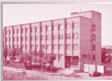
Производственная база на ул. Качалова, 17. Сдана в эксплуатацию в 1977 году
