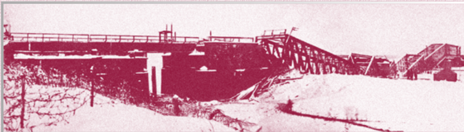
Разрушенный мост через р. Волхов на железнодорожной линии Москва — Ленинград
