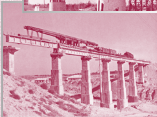
Поворотный консольный кран ГЭПК-130. Монтаж пролетных строений
