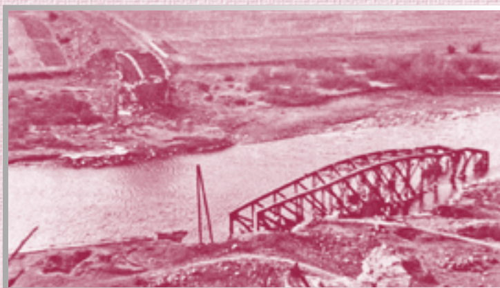
Разрушение моста через р. Стрый
