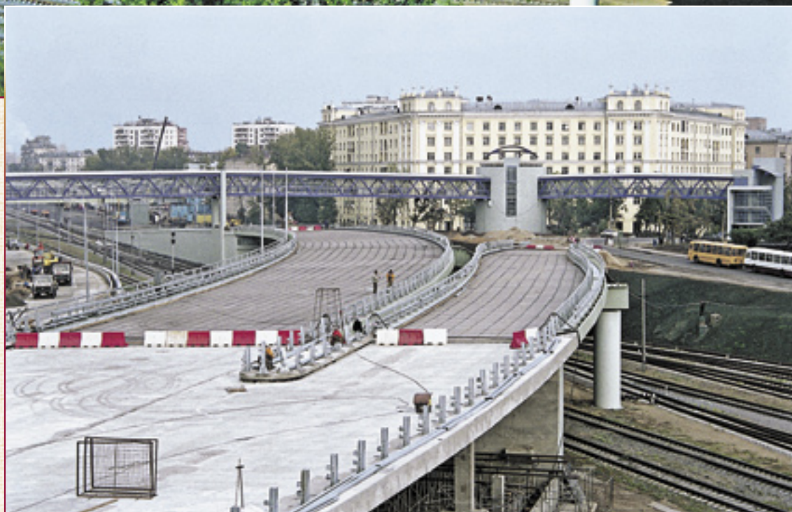
Сооружения у ст. метро «Автозаводская». Описание на стр. 51
