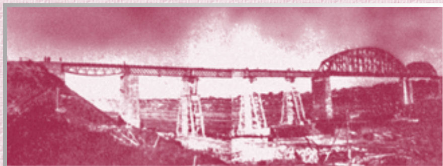
Временное восстановление моста через р. Волхов у г. Волховстрой
