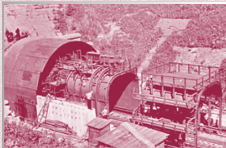
Тоннелепроходческий комплекс для капремонта тоннелей
