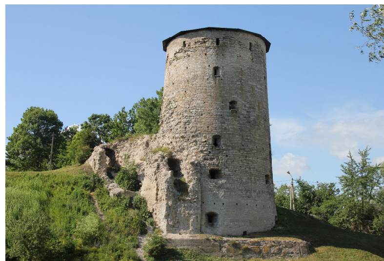
2. Комплекс крепостных сооружений Окольного города: Гремячая башня, XVI в.
