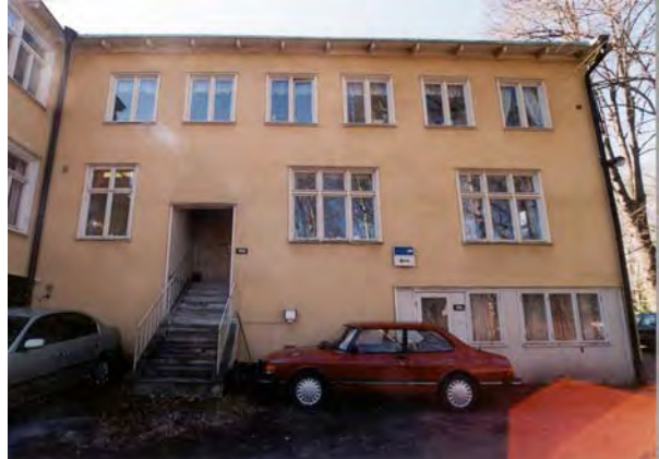
Entrésidan av delen tillbyggd 1925 och 1938. SBA 20040211-105
