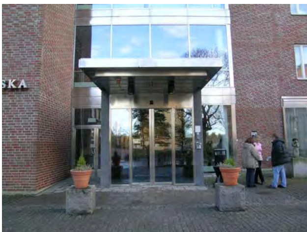
Entréparti i glas och stål. SBA 20040205-053
