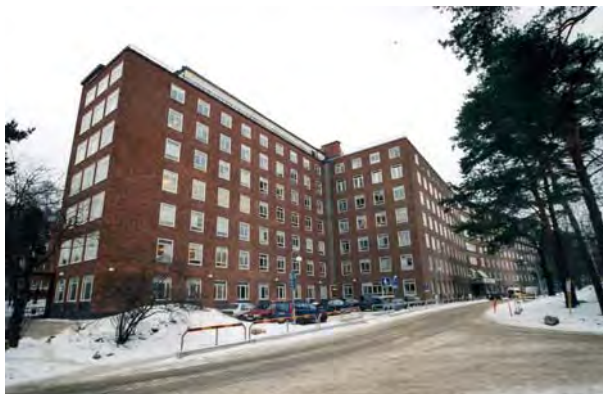
Fasad KS-parken. SBA 558-10
