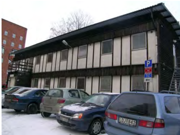
Fasad mot Z6. SBA 20040129-097
