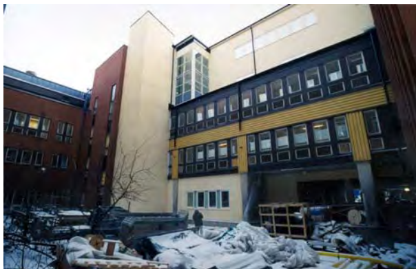
Förbindelsegången mellan F1 och C3 byggs in i den nya byggnaden. SBA 557-6
