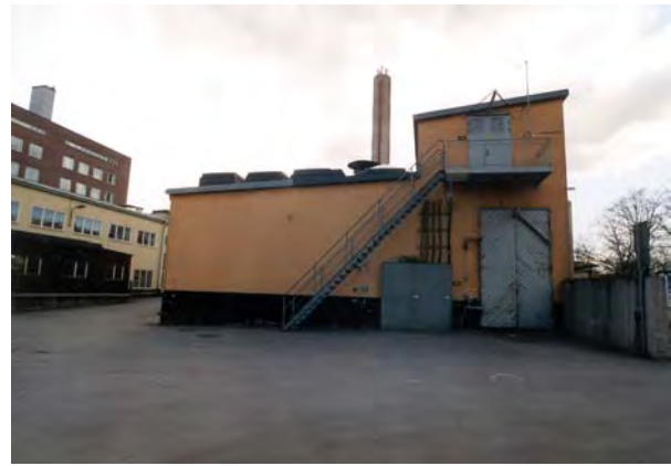
Kortsidans fasad. SBA 368-20
