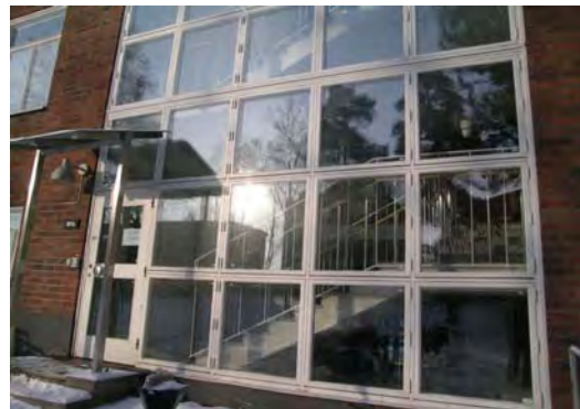
Luftigt trapphus med ursprungliga fönsterpartier. SBA D20040129-079
