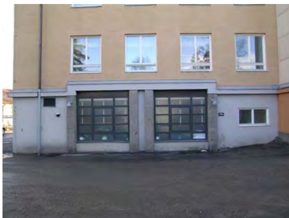
Två större fönsterpartier i bottenvåningen med granitomfattningar. SBA 20040205-134
