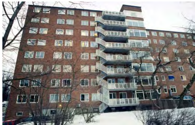
Fasad mot försörjningskvarteret. Brandtrappan är SBA 559-4
