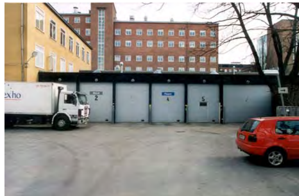
Utbyggd del för återvinning framför den ursprungliga förbindelselängan. SBA 372-9
