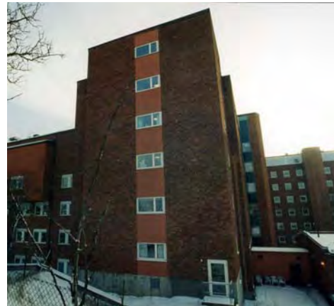
Gavel med rödputsat fönsterband, troligen en anpassning till "burspråket" på N10. SBA 559-20
