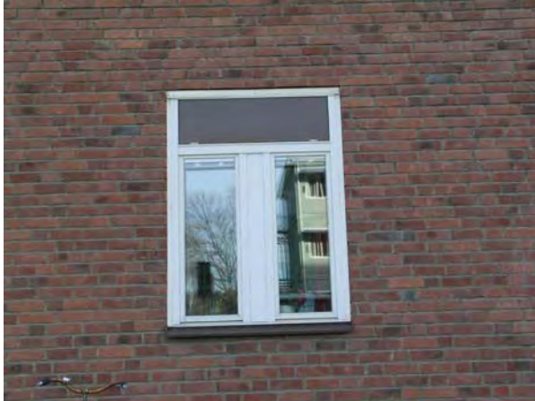
P1. Fönstren är utbytta. SBA 200403060-067
