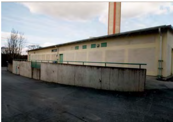
Fasad mot syd-väst. SBA 369-7
