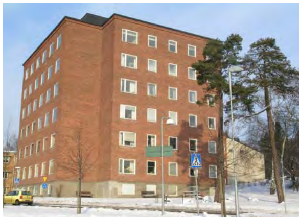
Tegelfasader med skift av stående tegelstenar närmast ak och sockel. SBA D20040129-070
