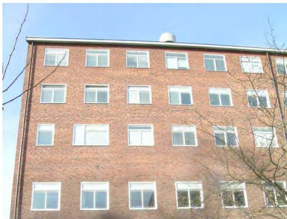
De påbyggda våningarna har aningen ljusare tegel än den ursprungliga byggnaden. SBA 20040306-038
