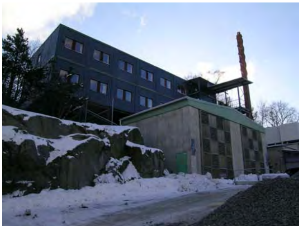
Byggnad för elförbrukningen. SBA 20040211-092
