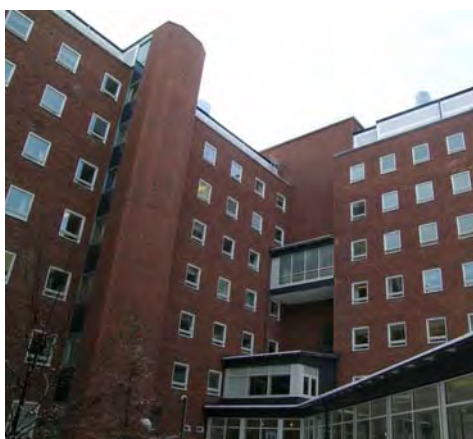
Gårdsfasader, N1 och N3, nybyggt trapphus? SBA D20040129-048
