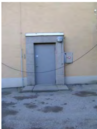
En dörr på baksidan med granitombfättning. Annars sker entré via S1. SBA 200400205-139
