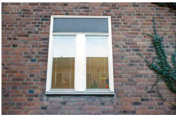
Nya fönster med brun glasskiva i den övre liggande luften. SBA 556-7
