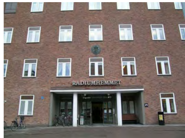
P1 Entrépartiet, dörrarna är utbytta till brunloxerade aluminiumpartier. SBA 20040205-002
