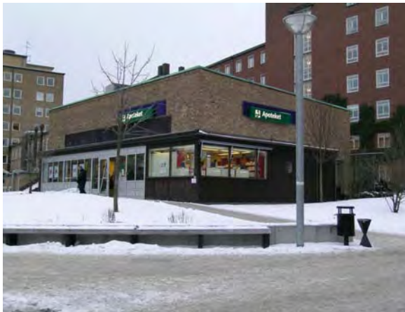
Apoteksdelen, ombyggd entréparti. SBA 20040123-018
