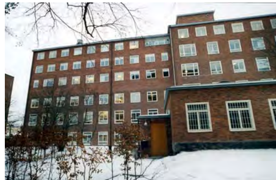
Fasad mot gården. SBA 558-18
