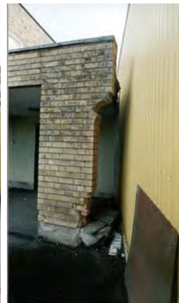
Loggians högra del kapades för att få plats med ett nytt kylrum. SBA 369-12
