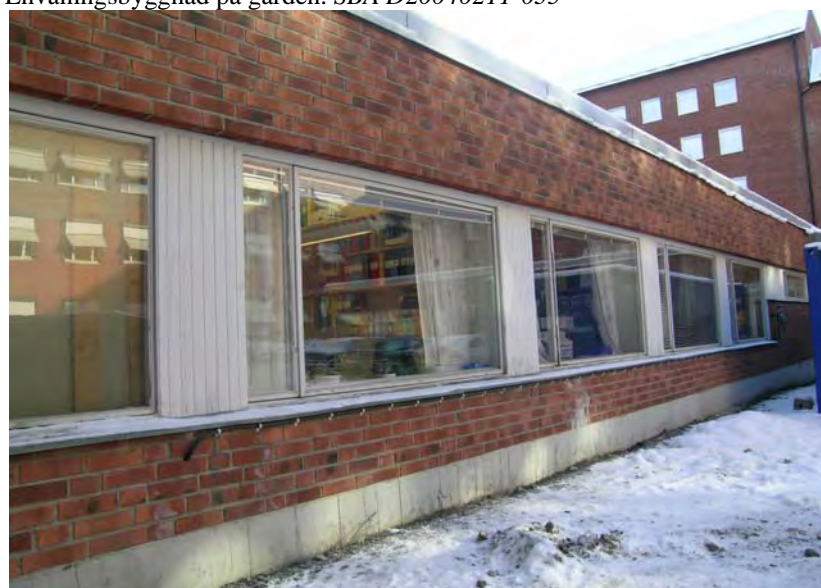
Fönsterband med träpartier. SBA D20040211-038
