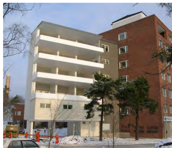
Öppen solaltan på pelare. SBA D20040129-016
