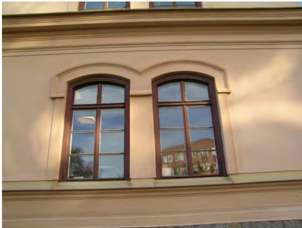
T1 Ursprungliga fönster. SBA 20040205-074
