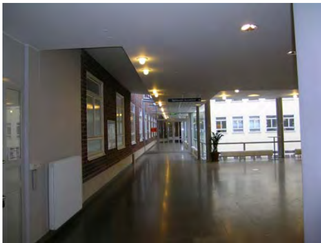
Förbindelsegång i glas/stål. SBA 20040306-111
