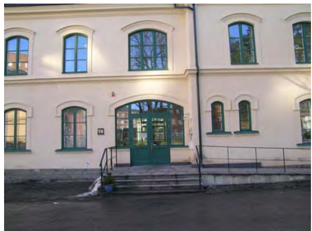
T4 Nyrenoverad entré. SBA 20040205-079
