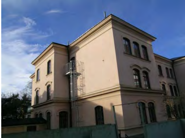
T1 Baksidan och en kortsidans fasader. SBA 20040205-073
