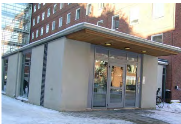
Nybyggd putsad entré till L7 som ligger utmed L2. SBA D20040211-012
