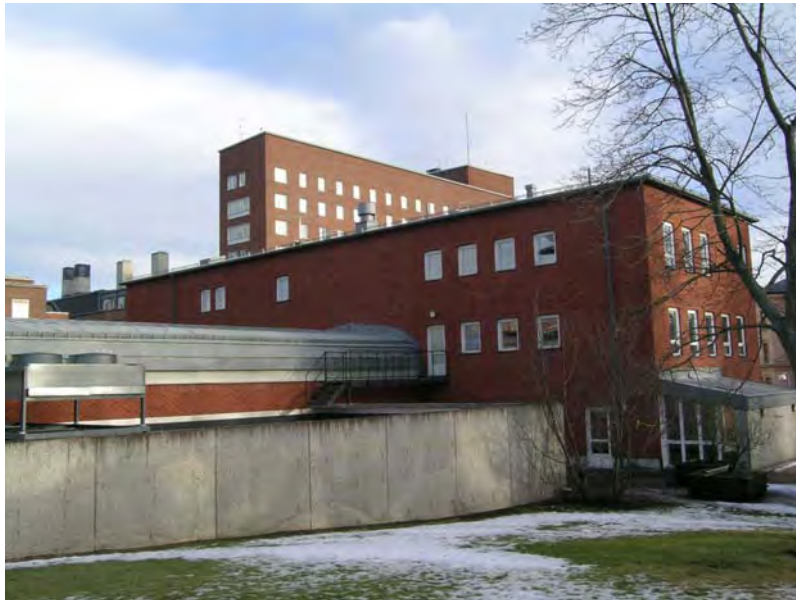
P8b Baksidan på den tillbyggda delen. SBA 20040205-019
