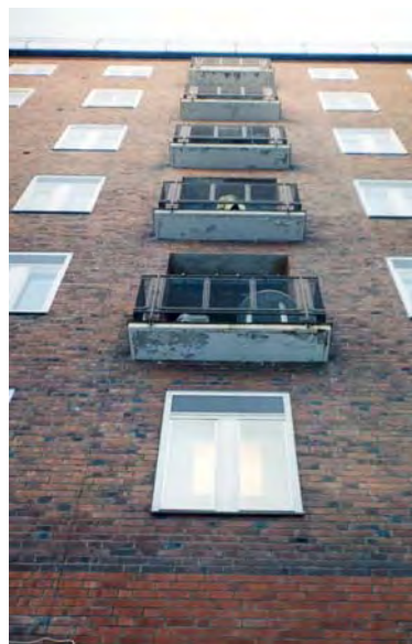
Ursprungliga balkonger med trådräcke på fasaden mot den inre parken. SBA 557-18
