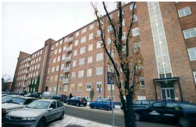
Fasad mot karolinska vägen. SBA 558-22
