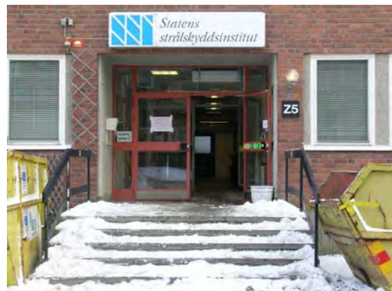
Ursprungligt entréparti med rödmålade stålpartier. SBA 20040129-098
