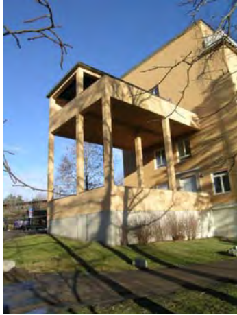
Balkongbyggnad på kortsidan. SBA 200400205-145
