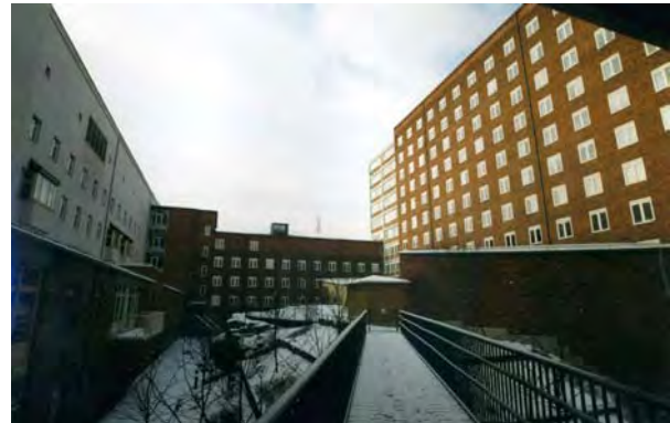
Fasad mot innergården. SBA 560-12a
