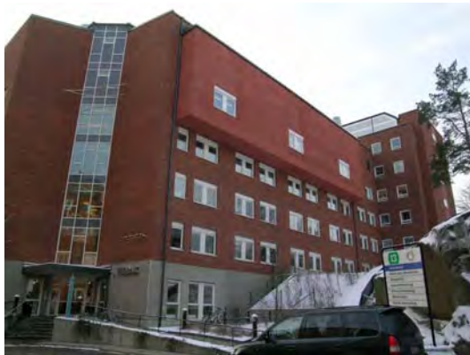
N10 med putsat "burspråk", detalj som hämtats från N2 och N3. SBA D20040129-039
