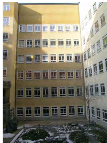
Fasaden på andra sidan av A7. SBA 20040306-107
