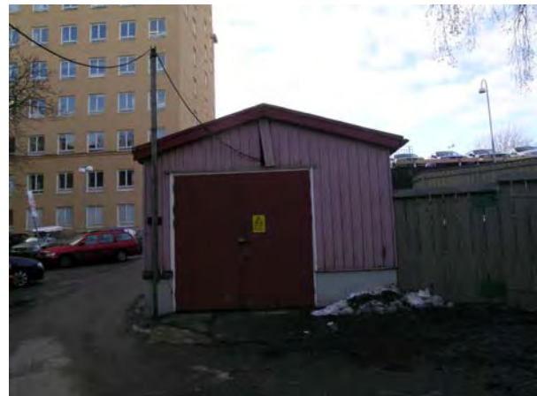
Garageporten på kortsidan är av smal stående träpanel. SBA 200400205-119
