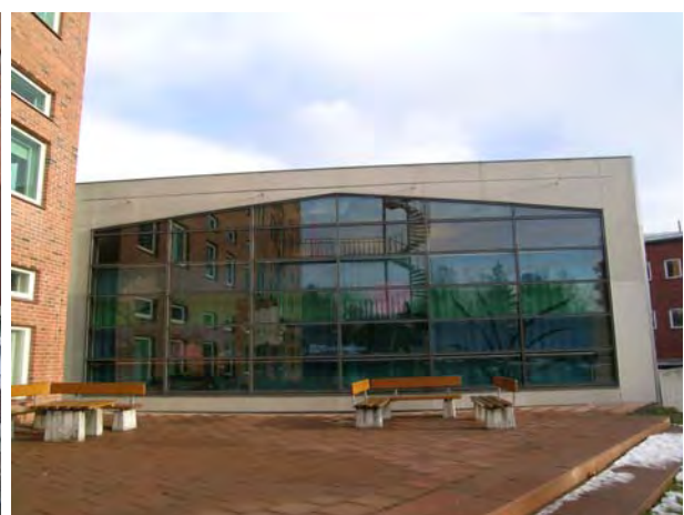
Utskjutande parti av P9. SBA 20040205-018
