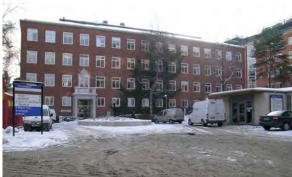
Huvudfasad med ursprungliga fönster. SBA D20040129-082
