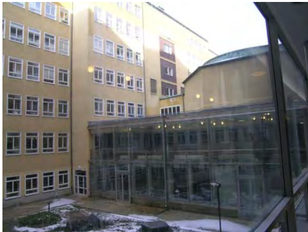
Den sexkantiga aulabyggnaden som ursprungligen låg fritt på innergården är numera påbyggd med en förbindelsegång av stål/glas. SBA 20040306-113
