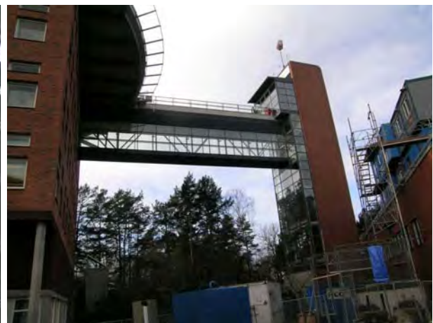
Fristående trapphus. SBA 20040205-012
