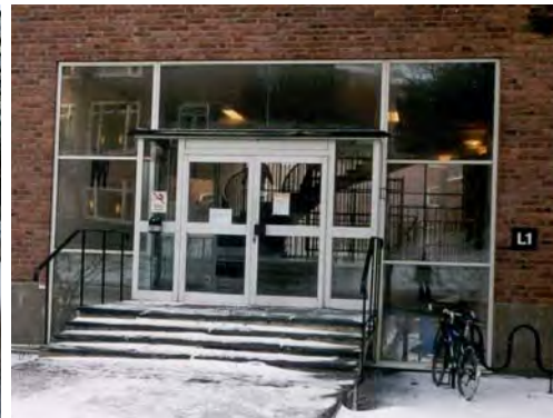
Huvudentré med utbytt dörrparti men ursprunglig glasnig. SBA 426-19
