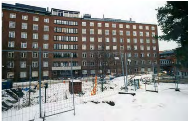
Fasad mot KS-parken. SBA 558-6
