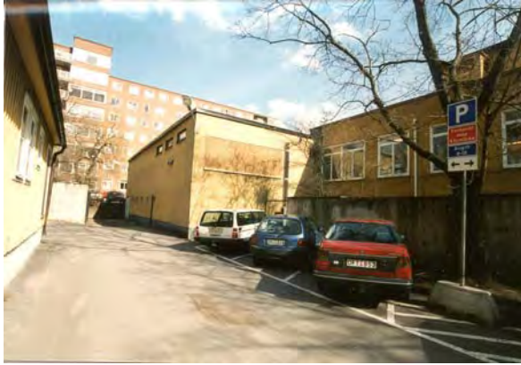
Del mot nordväst tillbyggt 1975 för att rymma nytt diskrum. SBA 369-17
