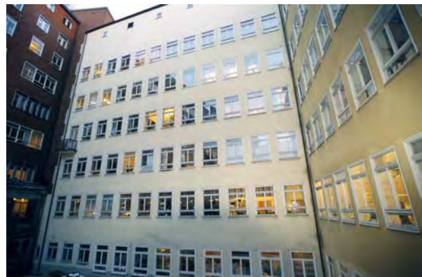
Fasad mot innergården. SBA 558-1
