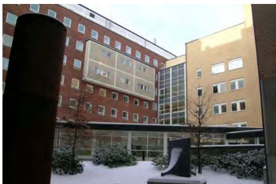
Gårdsfasad med putsat burspråk. SBA D20040129-043
