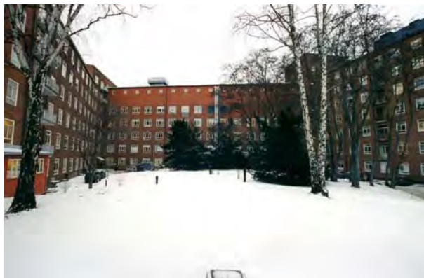
A3: s fasad mot parken, påbyggd med en våning 1971. SBA 558-13
