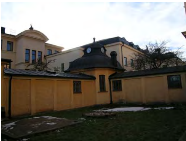
Spritputsade fasader på korsgången mellan T1 och T2. SBA 20040205-071
