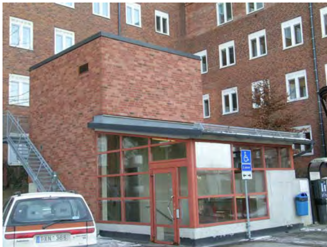
Ingång från övre parkeringsdäcket. SBA 20040306-061
