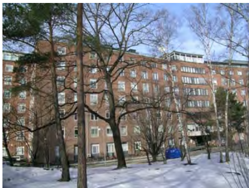
Fasad mot KS-parken. SBA 20040306-044
