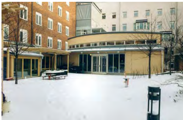
Tillbyggnad från 1994, innehållande en bassäng. SBA 560-9a
