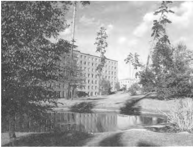
Huvudbyggnadens södra fasad mot Karolinska sjukhusparken, A2 och E1.
