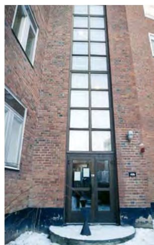
Vertikalt fönsterband vid trapphuset. SBA 557-10
