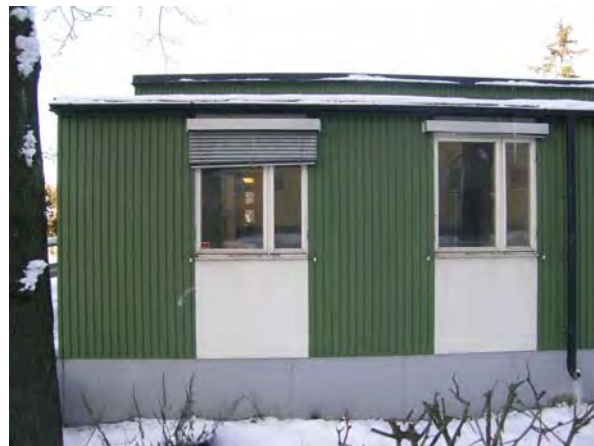
Fönsterpartier på långsidan mot Karolinska väg. SBA D20040211-084
