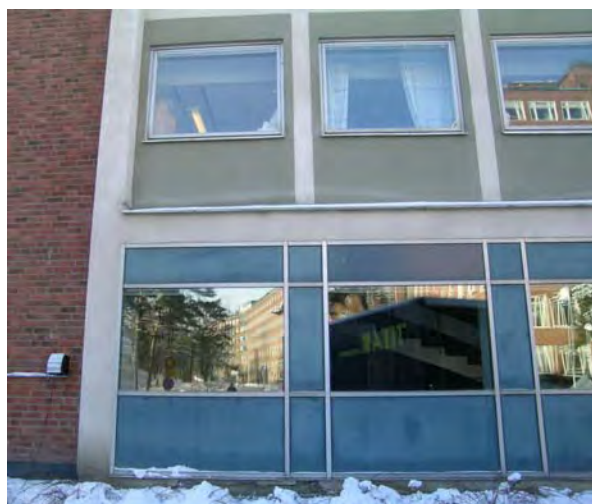
Detalj av huvudfasaden med skivinklädnad på bottenv. och ädelputs däröver. SBA D20040211-015
