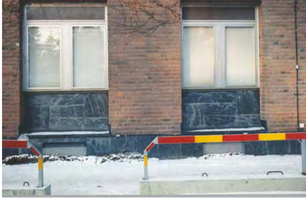
Svart skiffersten som sockel och fält under fönstren. SBA 557-21
