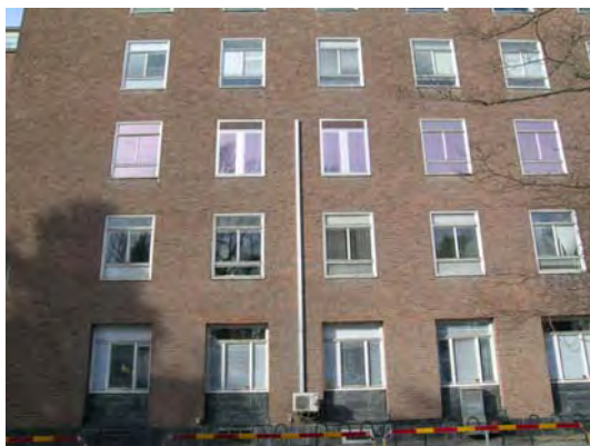
Fasad mot KS-parken SBA 20040306-045
