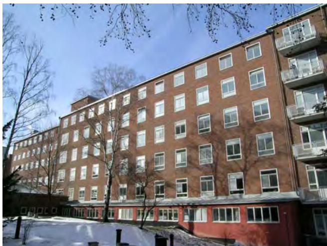
Fasad mot gården. SBA 20040306-035
