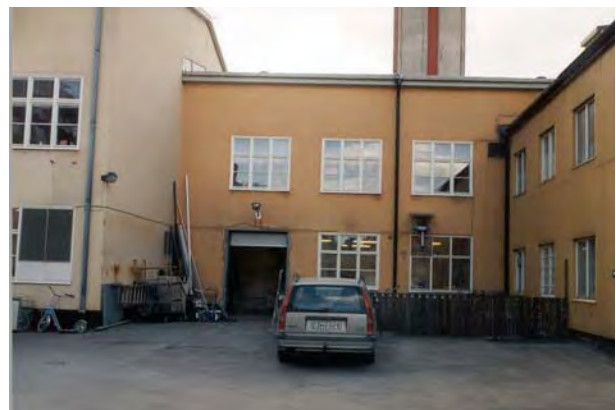
Tillbyggd del från 1952, fasad mot gården. SBA 368-23
