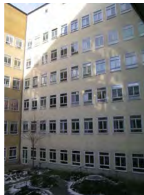
Fasad mot innergården. SBA 20040306-108
