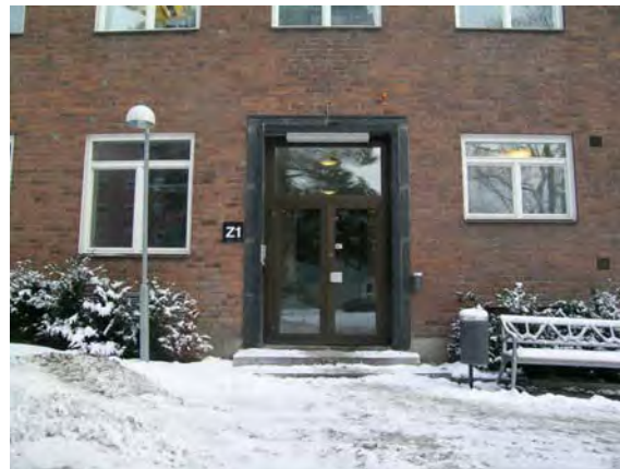
Svart skiffersten omfattar dörröppningen, dörren är dock utbytt mot ett aluminiumparti. SBA 20040129-109
