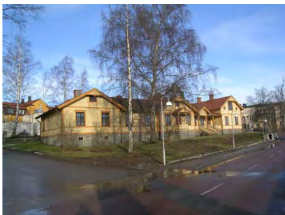
Fasad mot Stockholm stad. SBA 20040205-092
