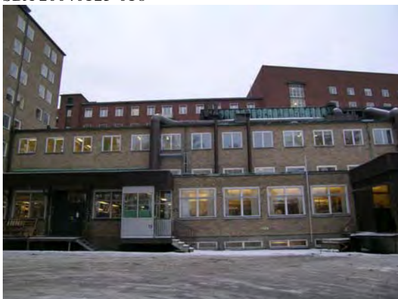
Baksidan av H3 är tillbyggd vid flera olika tillfällen. SBA 20040123-021
