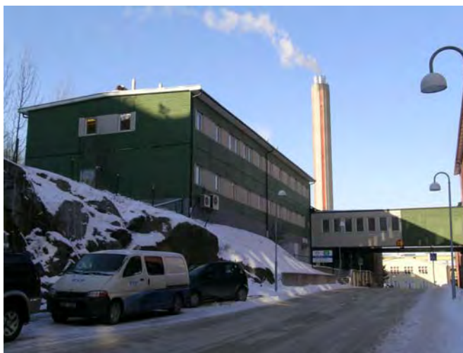
Barackbyggnad på höjden, förbindelsegång till L4. SBA D20040211-070
