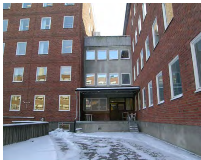
Gårdsfasaden, länkbyggnad mot L2. SBA D20040211-046
