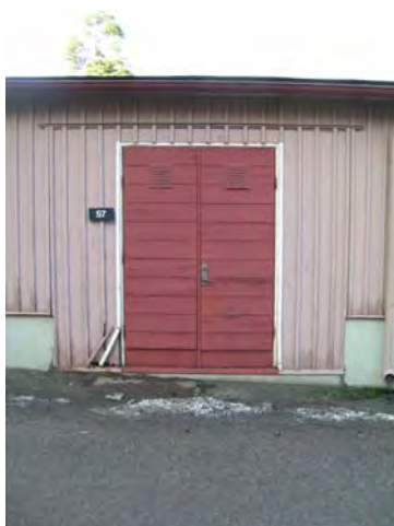
Dörrportarna på långsidan har liggande panel. SBA 200400205-119
