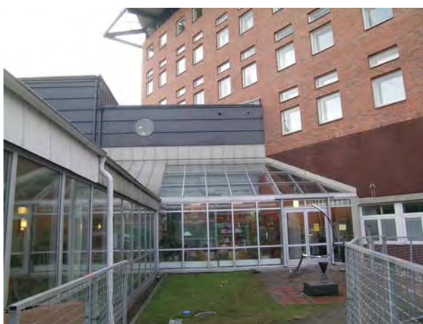
Vindfånget mellan P8 och P9 tillkom 1998. SBA 20040205-010
