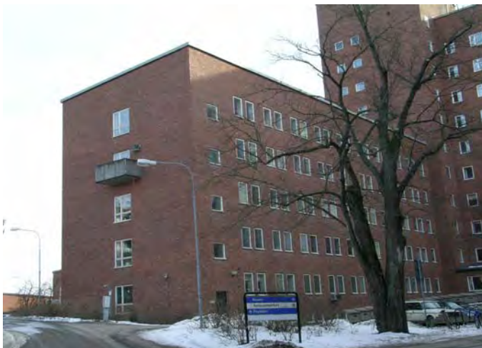
Fasad mot innergården. SBA 20040306-069
