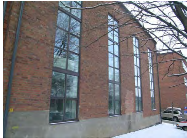
Fasaderna av rött tegel knyter an till de ursprungliga byggnaderna. SBA 20040129-104
