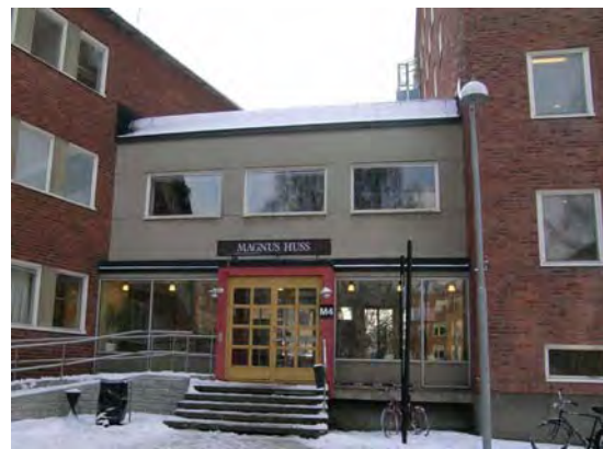
Länkbyggnaden mellan M3 och M4 med ädelputsade fasader. SBA D20040129-058
