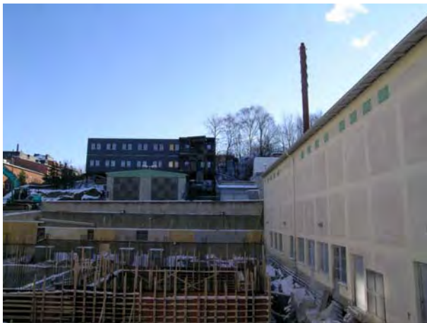
Tillbyggnad under uppförande. SBA D20040211-087
