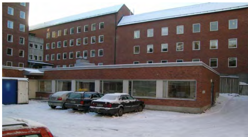
Envåningsbyggnad på gården. SBA D20040211-035
