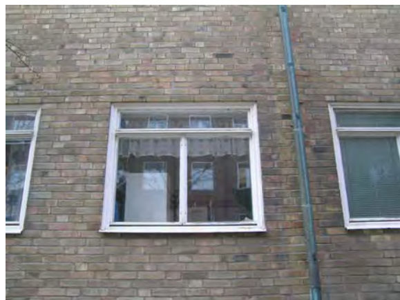
Ursprungligt fönster och stuprör av koppar. SBA 20040306-054
