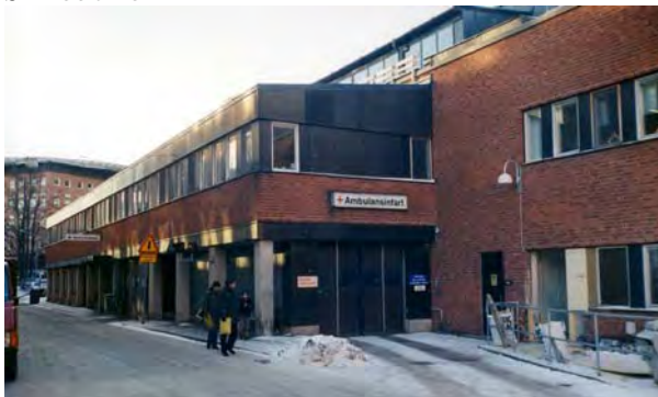
Fasad mot radiumhemmet, akutmottagning. SBA 556-10
