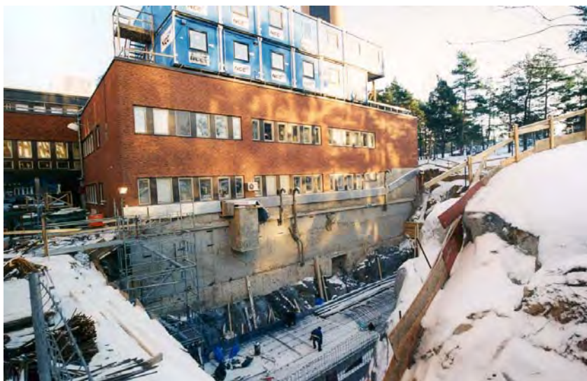
En tillbyggnad till F2 pågår. SBA 556-25
