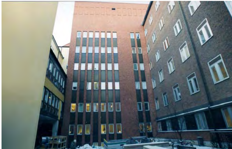
Fasad mot innergården. SBA 557-2
