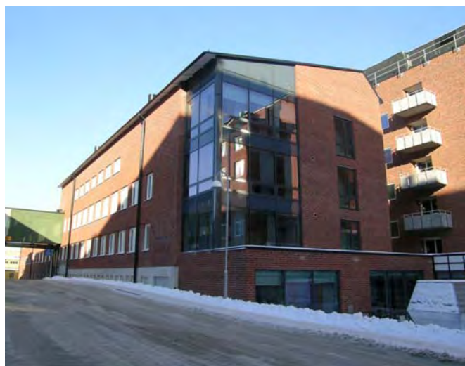
Tillbyggd gavel. SBA D20040211-066
