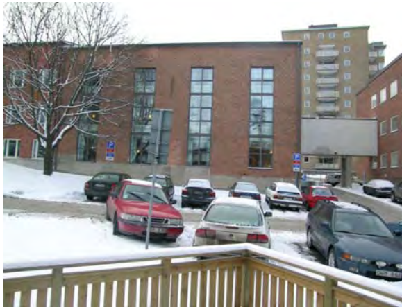
Fasader mot Solnavägen. SBA 20040129-101
