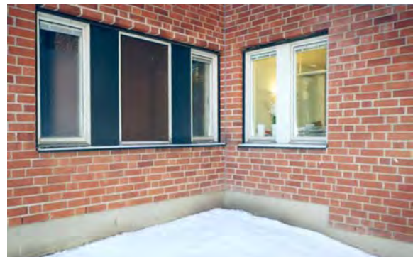
Fönster med aluminiumskivor mellan. SBA 556-14
