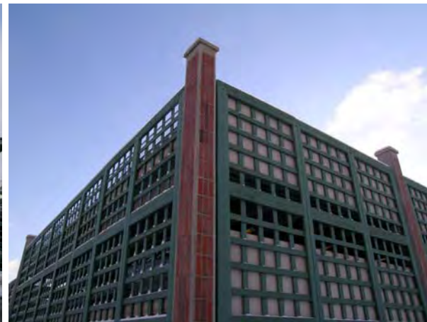
Pelare klädda med klinker. SBA D20040211-129
