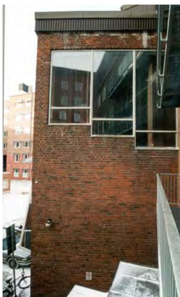
Stålfönster i föreläsningssalen. SBA 426-14
