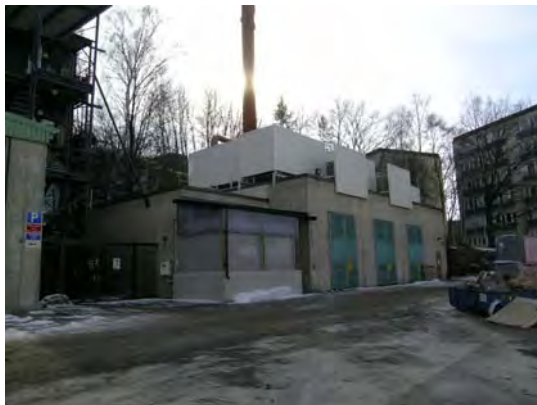
Byggnad för elförbrukningen. SBA 20040306-021
