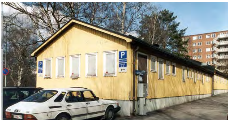
Baksidans fasad. SBA 368-4
