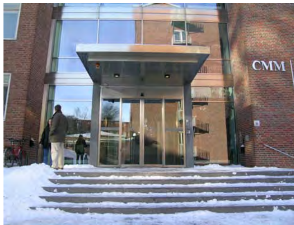
Huvudentré med glas, rostfritt stål och skiffer. SBA D20040211-022
