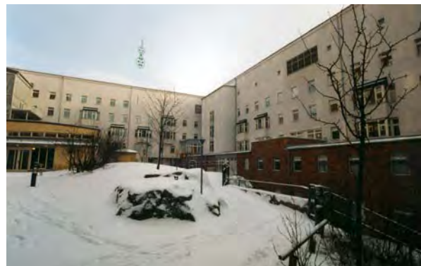
Q6:s fasader mot innergården är ljus putsade. SBA 560-7a
