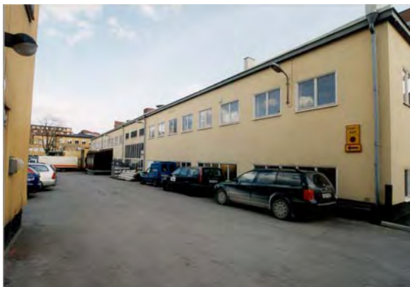
Fd tvättbyggnadens fasad in mot gården. SBA 369-9
