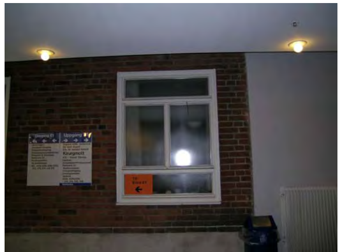
Ursprungligt fönster, numera inbyggt. SBA 20040306-110
