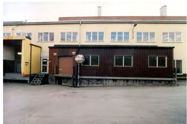
En äldre lastkaj har byggts in med korrigerad plåt. SBA 369-10
