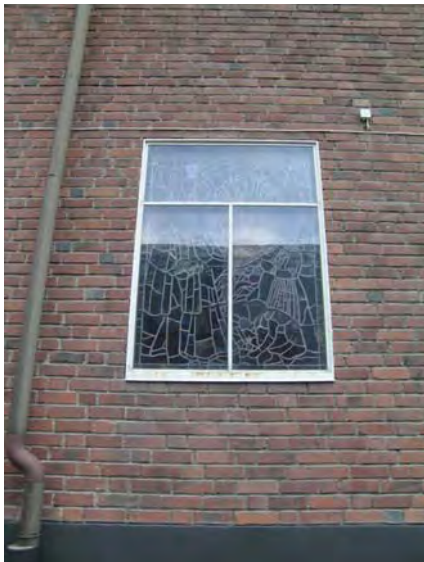
P3 Fönster med mönstrat glas vilket ursprungligen gav ljus in till väntrummet. SBA 20040205-004
