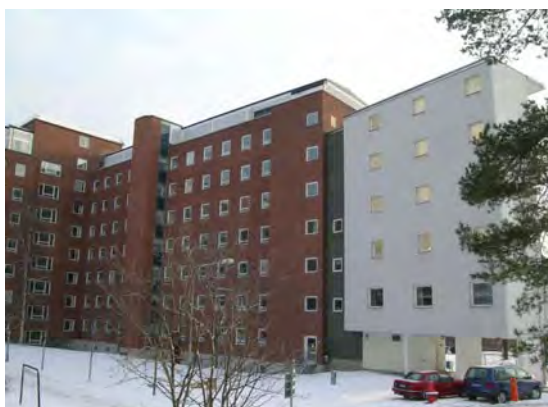
Baksidan med utanpåliggande schakt. SBA D20040211-020
