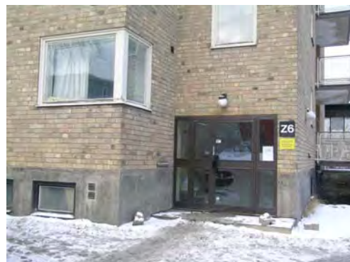
Utbytt entréparti. SBA 20040129-093
