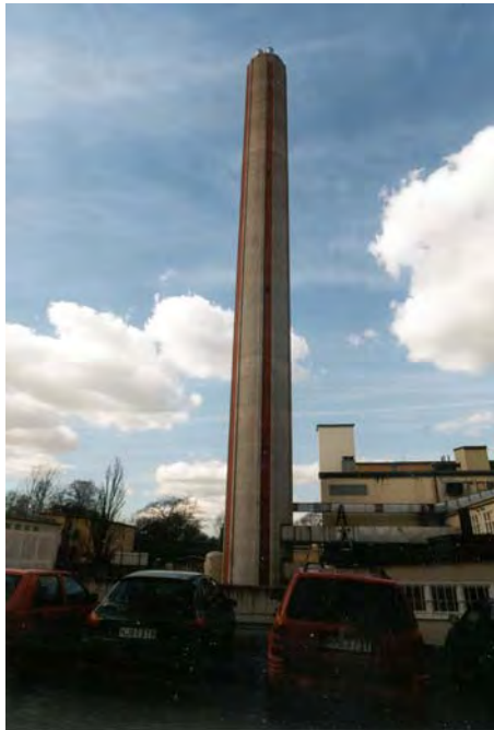
Skorstenen stod tidigare på gården men flyttades på 1990-talet till sitt nuvarande läge. SBA 369-3
