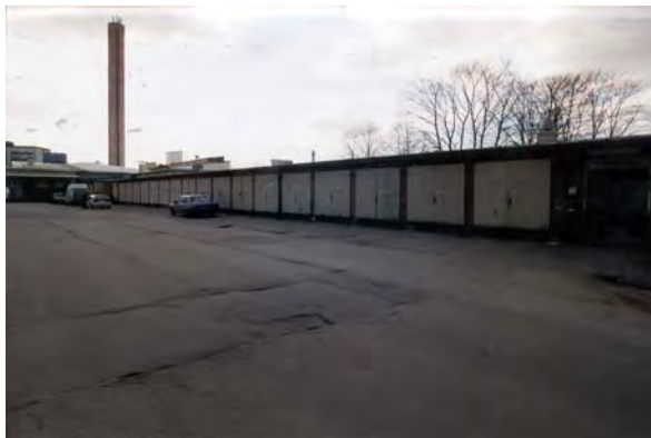
Fasad mot inre förbindelsevägen. Garagen fungerar numera som förråd. SBA 369-14
