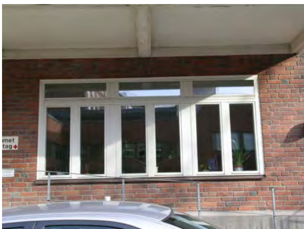
P5 Fönsterband vid sidan av entrén. SBA 20040306-072
