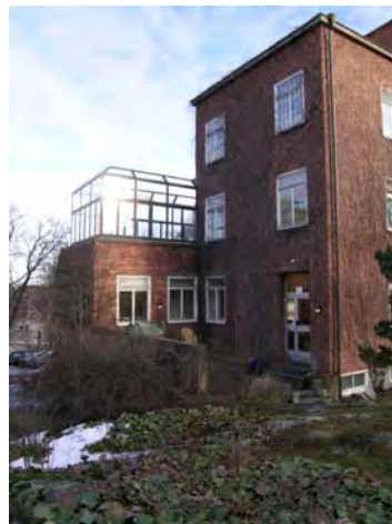
Balkongbyggnad på kortsidan. SBA 20040205-038
