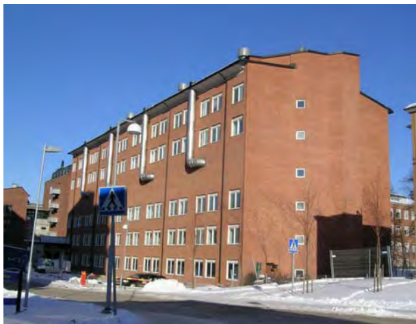
Typiska utanpåliggande ventilationsrör, veckad gavel. SBA D20040211-002
