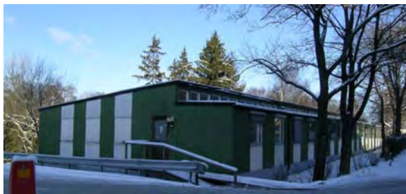
Fasad mot Karolinska väg. SBA D20040211-083
