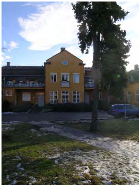
Fasad mot KS-parken. SBA 20040205-109
