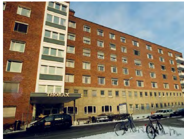
Huvudfasaden med entrén till N2 i förgrunden. SBA 559-17
