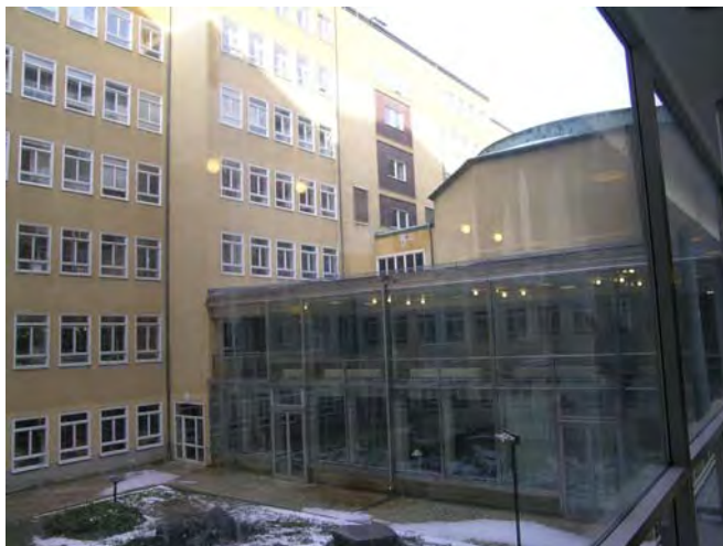
A6:s fasader mot innergården. SBA 20040306-113
