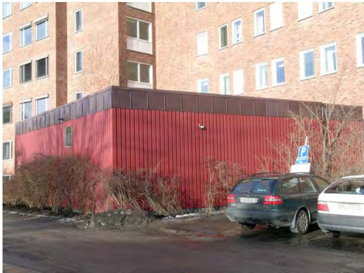
Tillbyggnad av korrigerad plåt. SBA 20040205-058
