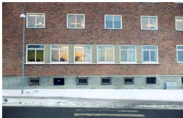
Fönsterband på fasaden mot busstorget. SBA 559-6
