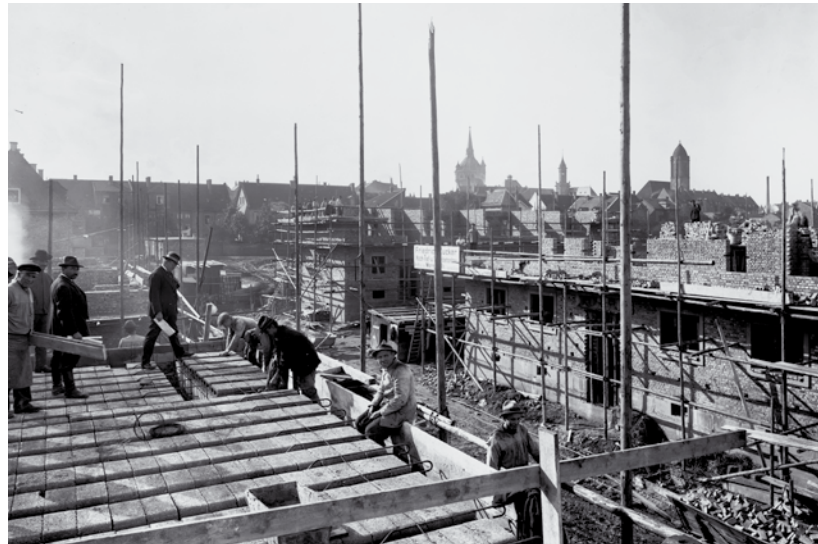
Maßnahmen zur Bekämpfung der Wohnungsnot Bauarbeiten in der Seidenbenderstraße im Oktober 1925
