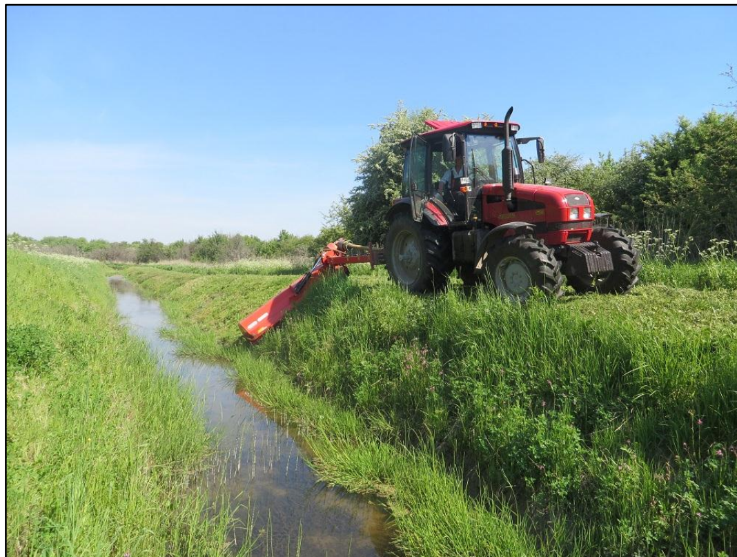
Рис. 4.7. Работы по уходу за мелиоративной сетью в ЗАО «Труд», Неманский район.
