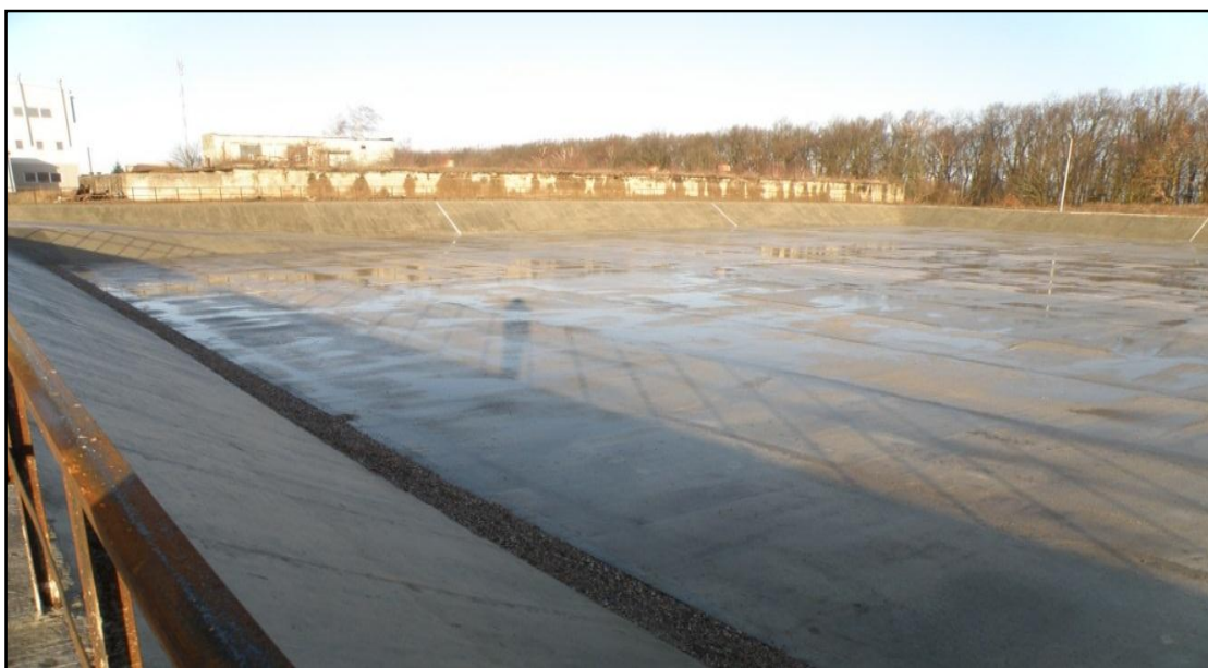
Рис. 3.19. Иловая площадка АО «ОКОС» после реконструкции.
