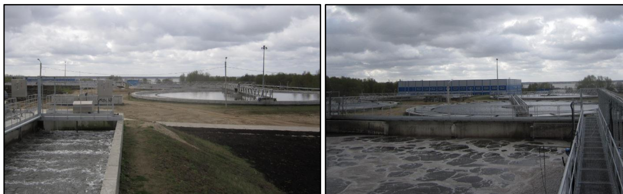
Рис. 3.20. Очистные сооружения г. Калининграда.
