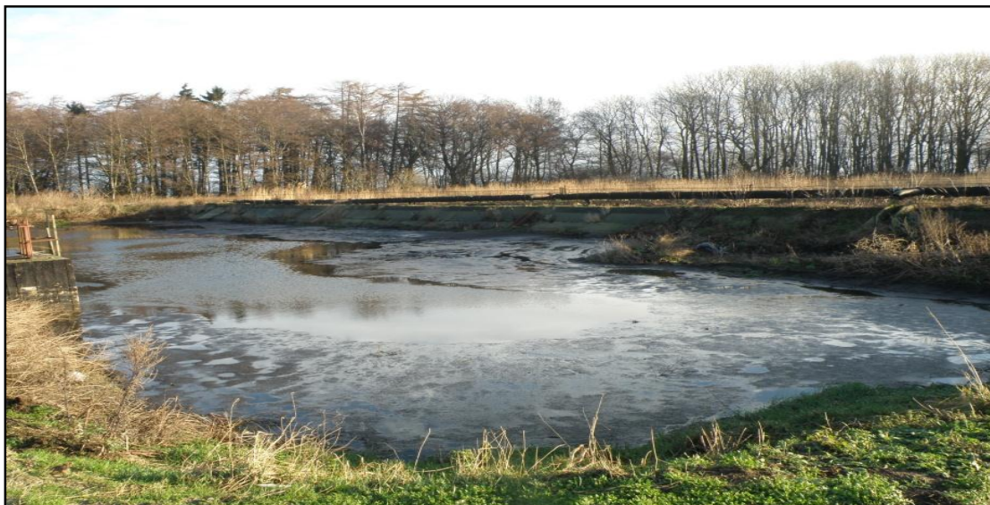
Рис. 3.18. Иловая площадка АО «ОКОС» до реконструкции.
