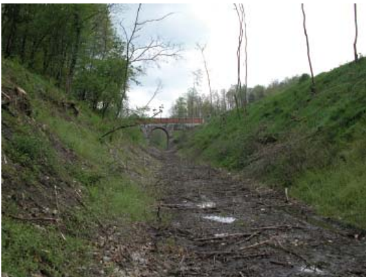
Le infrastrutture (anticamente definite "opere d'arte"), seppur in assenza dell'armamento, rivelano ancora la propria identità catalizzando l'immagine del contesto circostante. Ponticello in muratura a tre arcate ad Olgiate Comasco.
