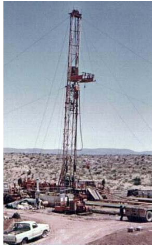
Figura 3.13: Perforación con recuperación de testigos a más de 1.000 m de profundidad
