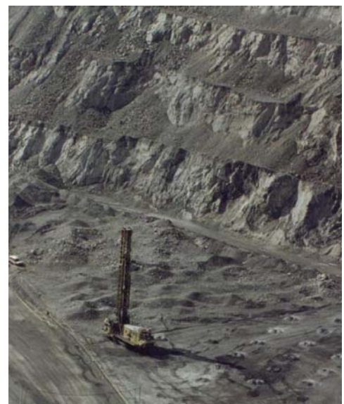
Figura 4.4: Perforación para voladura y avance en bancos
