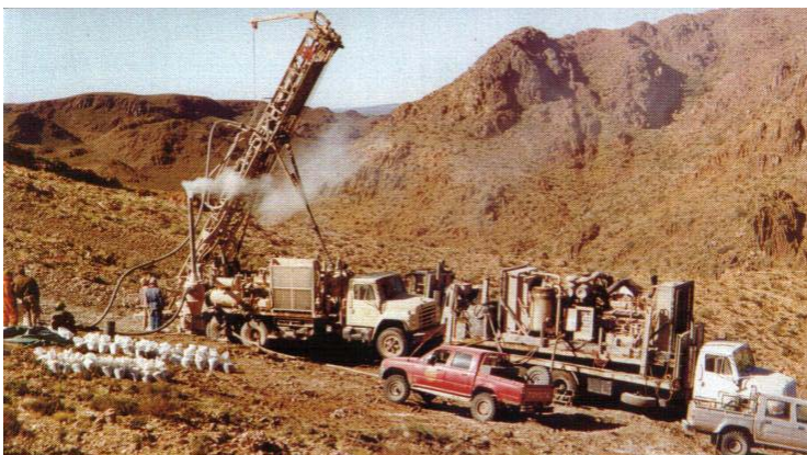
Figura 3.12: Perforación con recuperación de polvo.
