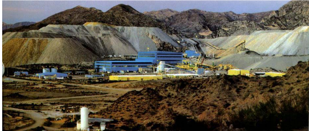
Figura 4.5: El mineral extraído de la mina Bajo de la Alumbreira es procesado en la planta industrial de tratamiento que se ve en primer plano. El material estéril es acumulado en la escombrera que se ve detrás de la planta.
