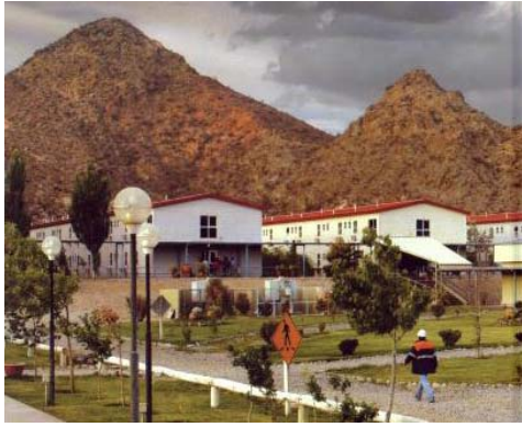
Figura 5.3. Mina de cobre y oro Bajo de la Alumbrera. Vista parcial del campamento destinado al personal de la empresa
