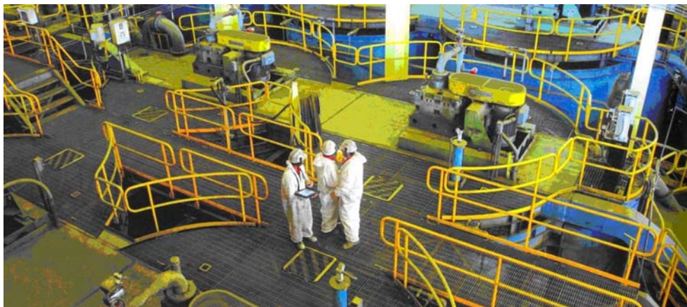
Figura 6.15: Interior de la planta de flotación de la mina Bajo de la Alumbrera
