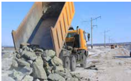
Фракционный камень заготавливается для охлаждающих берм вдоль насыпи
