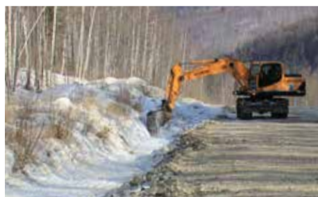
Для безопасного проезда насыпь дороги поднимают и очищают от льда водоотводные каналы
