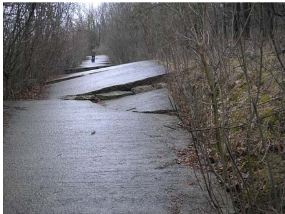
Foto nr. 16 Alee burdusita de alunecarea de teren (Gradina Botanica- Municipiul Iasi)
