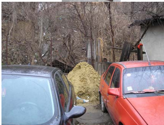
Foto nr. 15 Camin de drenaj decolmatat (Municipiul Iasi)
