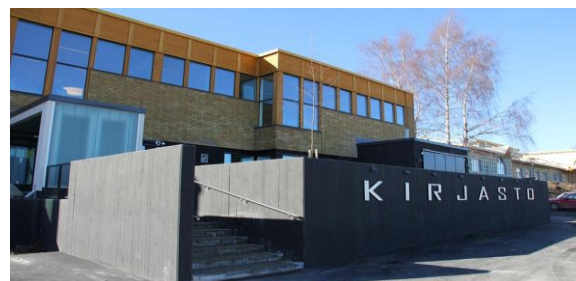
Peruskorjattu kirjasto Opintien suunnalta kuvattuna
