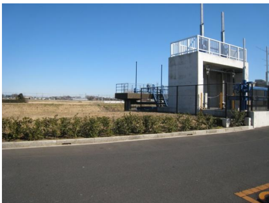
旧・城之上橋 (俗称、鷹匠橋) 跡地 現、花田第二樋門の北側にあった
