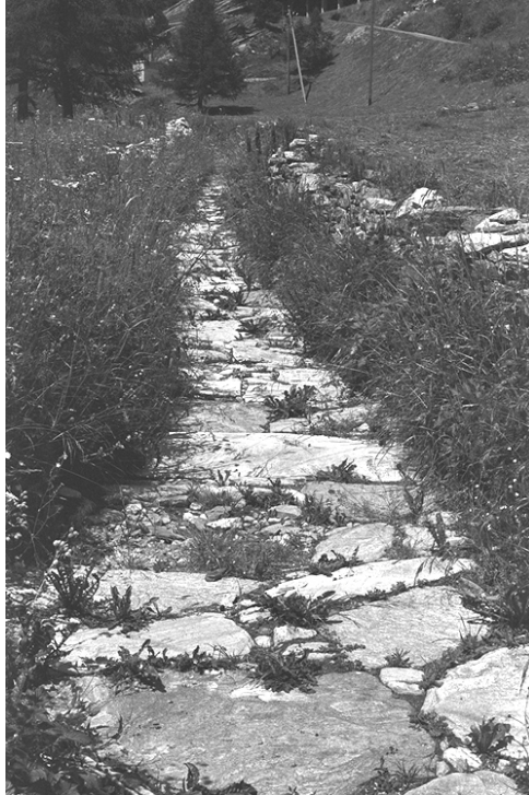
Plattenartige Pflasterung bei Maschihüs (VS 1.2.12). Abb. 6 (RF, 23. 7. 1993)
