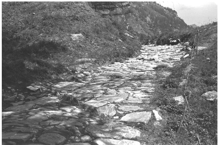
Pflasterung mit steilgestellten Steinen, Randsteinen und Querabschlägen zur Wasserableitung oberhalb Simplon Dorf (VS 1.2.4). Abb. 5 (RF, 23. 7. 1993)
