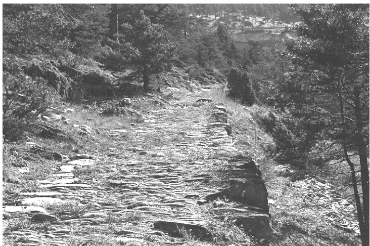
Besonders auf der Nordseite zwischen Riederwald und Taferna wird die Weganlage durch talseitige Stützmauern gesichert. Abb. 7 (RF, 14. 7. 1992)
