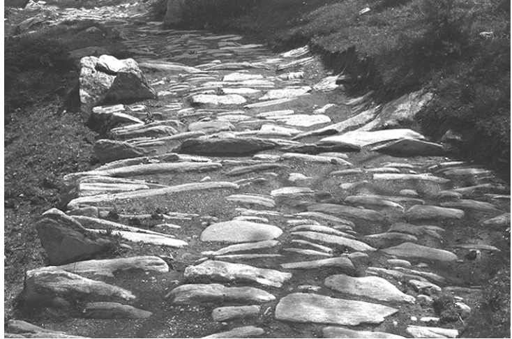
Pflasterung mit steilgestellten Steinen, Randsteinen und Querabschlägen zur Wasserableitung unterhalb der Passhöhe (VS 1.2.9). Abb. 4 (RF, 22. 7. 1993)
