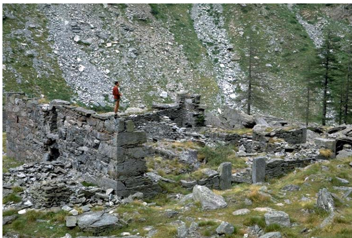
Ruinen der durch Stockalper geplanten, aber nie vollendeten Sust unterhalb von Gabi (Ortsbezeichnung Äbi; VS 1.2.16). Ein heruntergefallener Türsturz trägt die Jahrzahl 1676. Abb. 13 (Ae, 14. 7. 1964)
