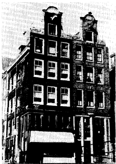
Egelantiersgracht 66-70 vóór en na de restauratie
