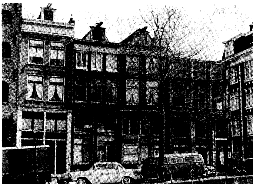
Prinsengracht 333-339 vóór de restauratie
