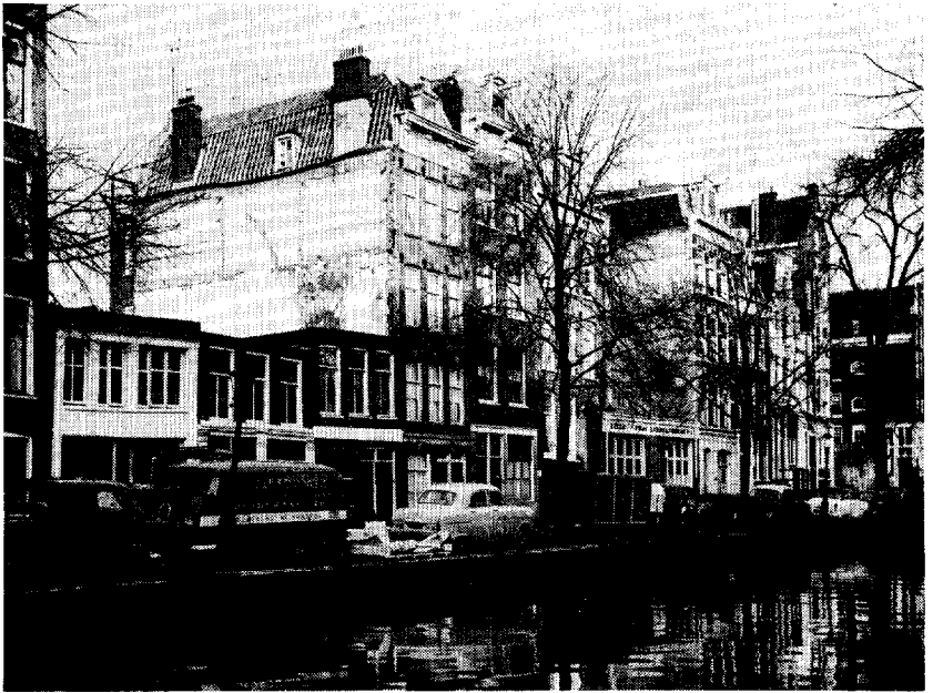
Noordelijke gevelwand van de Egelantiersgracht tussen Tweede en Derde Egelantiersdwarsstraat. In deze sterk aan verval onderhevige buurt staan de gerestaureerde monumenten Egelantiersgracht 66-68-70, waarvan het laatste op de boek van de Tweede Egelantiersdwarsstraat geheel rechts op de foto te zien is. Men zie voor deze panden de restauratiebriek in dit nummer.
