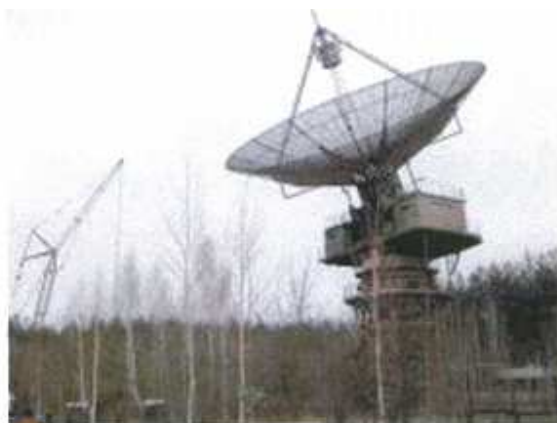
Cette station d'étude de l'ionosphère à Zmiev ( Ukraine) a été abandonnée après l'effondrement de l'Union Soviétique. 112
