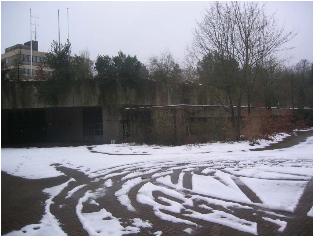
Kraftfahrzeughalle unter dem Parkdeck
