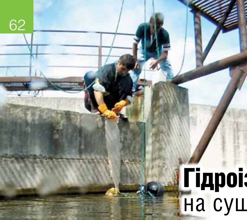
Гідроізоляція швів дюкера Хмельницької АЕС
