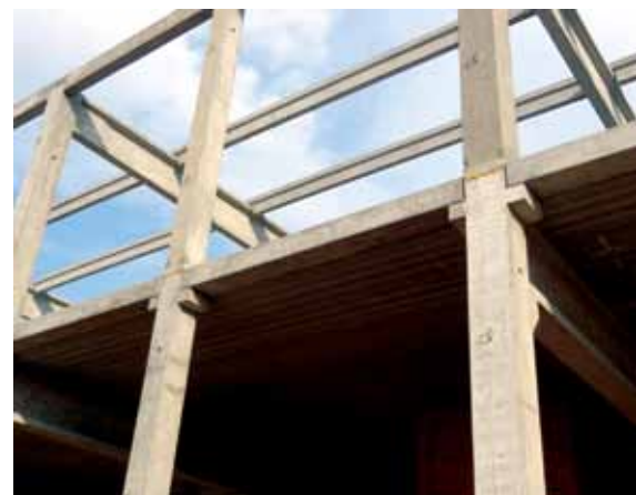
Вузол стикування колони, балок та плит
