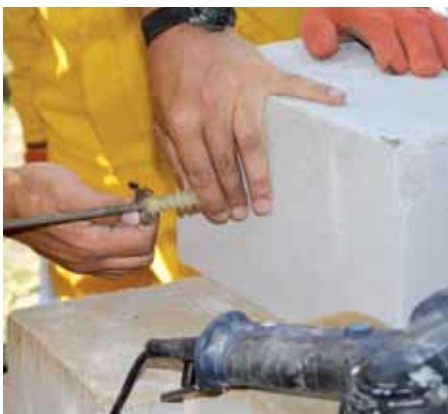
Серед важливих операцій – різка, штроблення, вирівнювання поверхні блоків, облаштування анкерних кріплень, практичне завдання по влаштуванню фрагмента стіни
