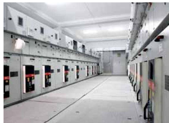
Головна розподільна підстанція потужністю 25 МВА
