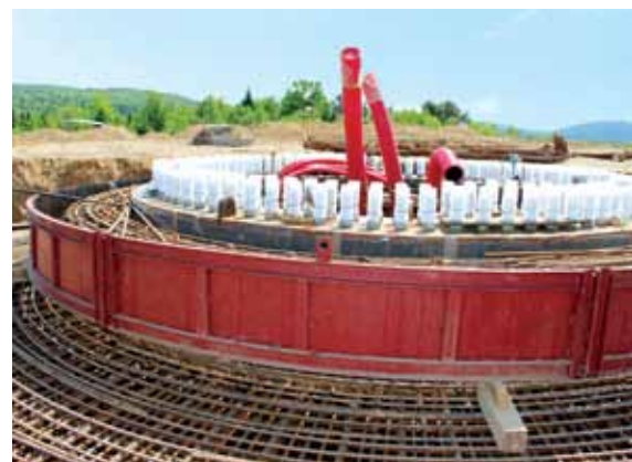
Змонтована верхня частина опалубки під заливку бетону
