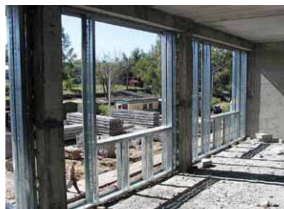
Вересень 2014 року: відліто бетонний каркас...
