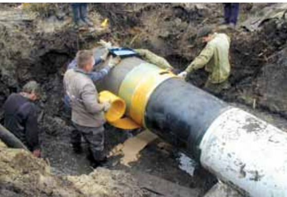
Ремонтний бандаж, встановлений на дефектну ділянку газопроводу, захищає його від подальшого руйнування
