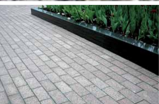
Сучасні технології та обладнання забезпечують ідеально рівні внутрішні грані колотої бруківки, а спеціальна обробка запобігає ковзанню
