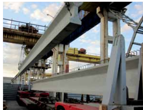
Встановлення мостових балок для пішохідних переходів та автодорожніх мостів
