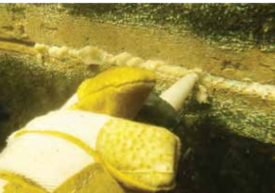
Заповнення полімерною композицією швів напірної дамби Хмельницької АЕС
