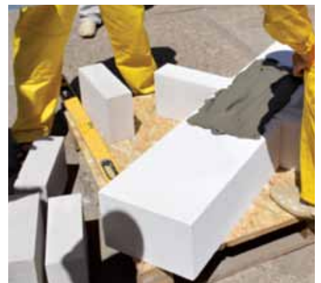
Серед важливих операцій – різка, штроблення, вирівнювання поверхні блоків, облаштування анкерних кріплень, практичне завдання по влаштуванню фрагмента стіни
