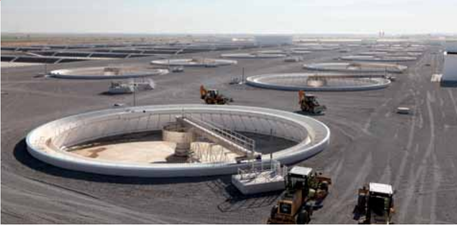
Вторинний відстійник діаметром 40 м; очищення здійснюється за сучасною технологічною системою
