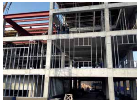
розпочато встановлення термопанелей...
