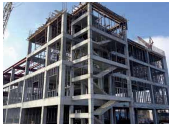
проводиться монтаж термопрофілю...
