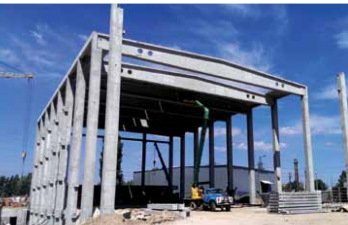
Знімальний павільйон по вул. Козелецькій
