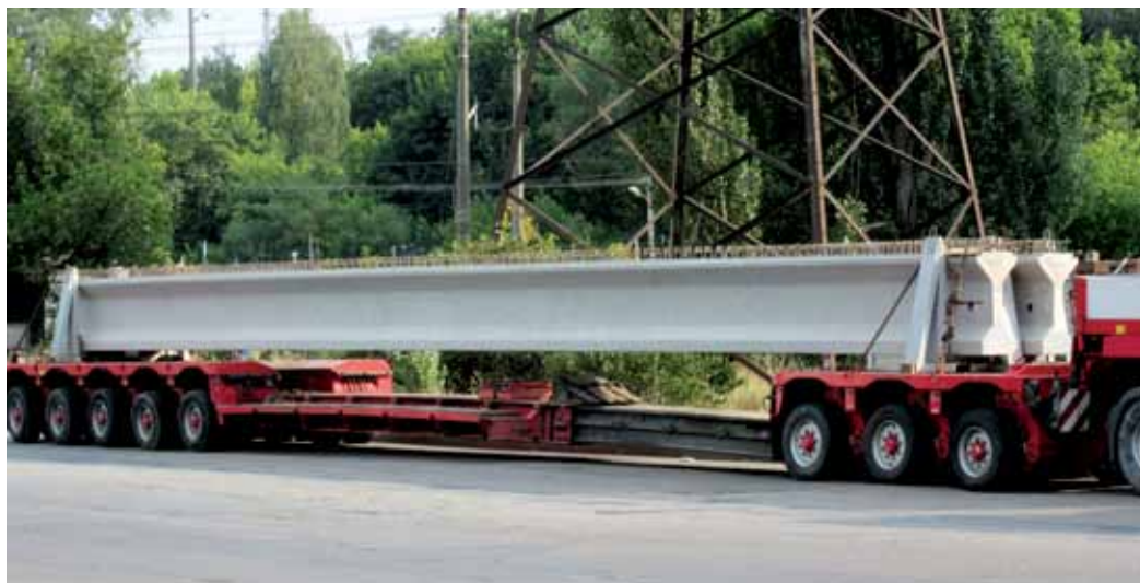
Транспортування мостових балок для пішохідних переходів та автодорожніх мостів
