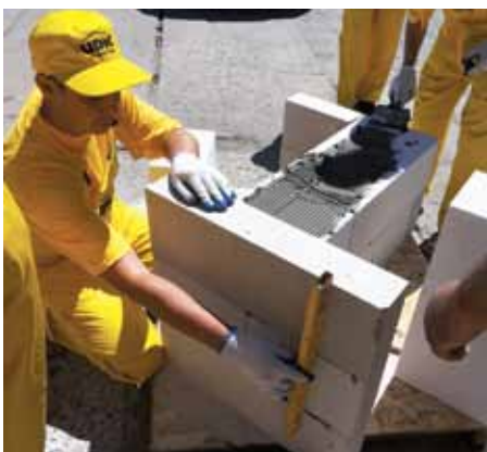
Під час заняття майстри відпрацьовують усі основні операції: самостійно готують клейовий розчин, виконують кладку першого і наступних рядів з примиканням стін
