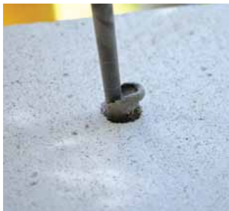
Серед важливих операцій – різка, штроблення, вирівнювання поверхні блоків, облаштування анкерних кріплень, практичне завдання по влаштуванню фрагмента стіни
