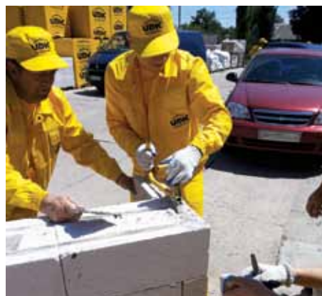
Під час заняття майстри відпрацьовують усі основні операції: самостійно готують клейовий розчин, виконують кладку першого і наступних рядів з примиканням стін
