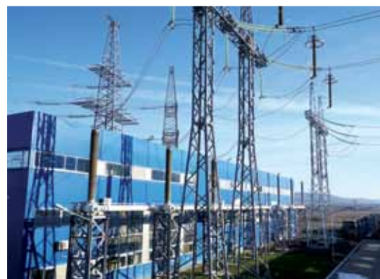
КРУЕ 330 кВ: комплексний розподільчий пристрій закритого типу з елегазовим устаткуванням
