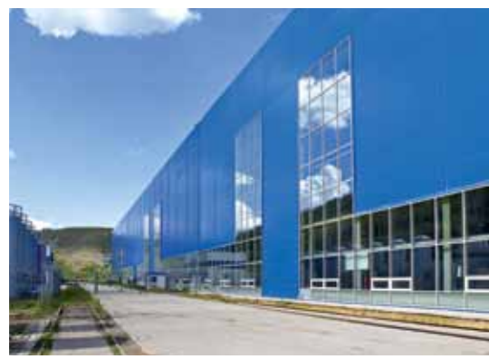
Монтажний зал довжиною 72 м
