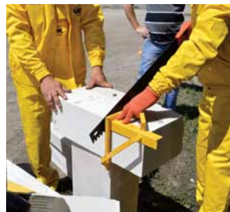
Під час заняття майстри відпрацьовують усі основні операції: самостійно готують клейовий розчин, виконують кладку першого і наступних рядів з примиканням стін
