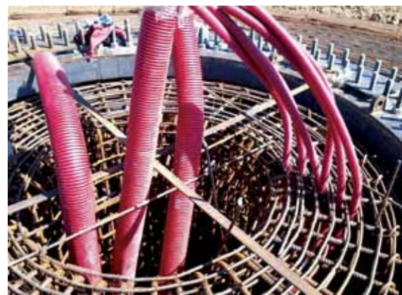
Монтаж арматури на місці фундаменту
