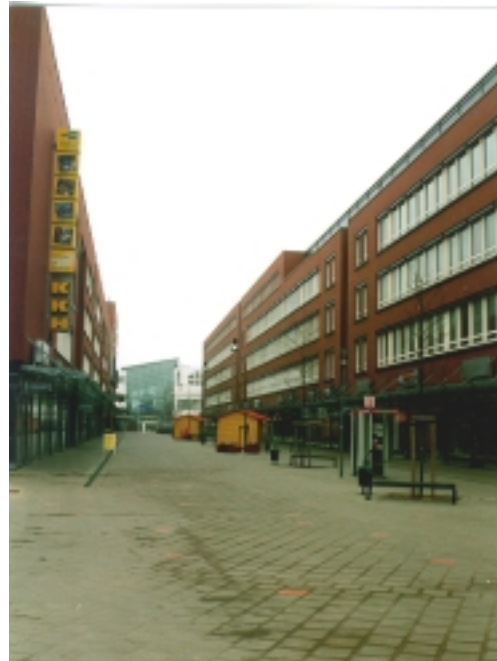
Lütten Klein, neue Zentrumsbebauung mit Fußgängerzone
