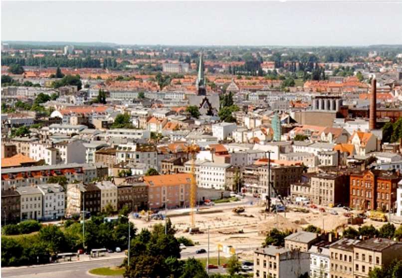
Kröpeliner-Tor-Vorstadt. Auf dem Bauplatz im Vordergrund am Schröderplatz entsteht gegenwärtig anstelle der alten Feuerwache ein neuer großer Büro- und Geschäftskomplex.
