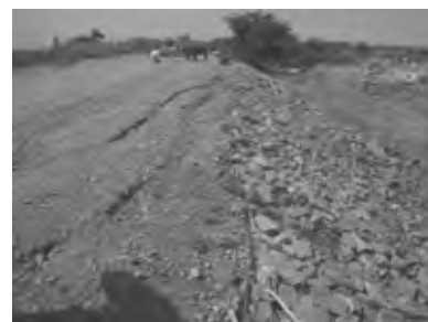
Renforcement de la digue droite à l'aval du pont-aqueduc du canal AD
