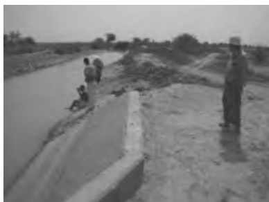
Renforcement de la digue droite à l'aval du pont-aqueduc du canal AD
