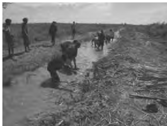
Dragage (nettoyage des canaux)
