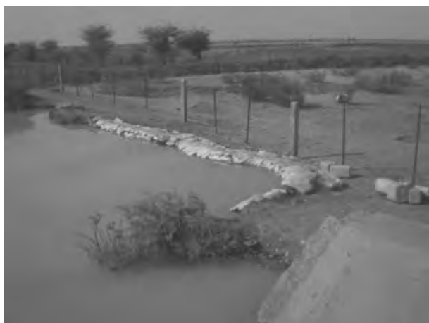
Exhaussement par les sacs de sable à S3
