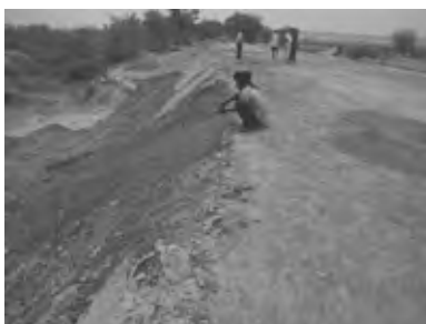
Renforcement de la digue droite à l'aval du pont-aqueduc du canal AD
