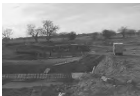
Construction du pont sur la route Kaédi-M'bout
