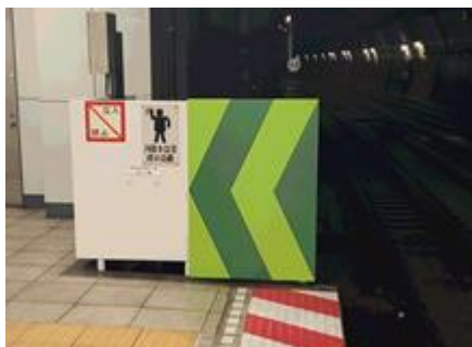
写真 1 視認性向上板 (試験設置)
