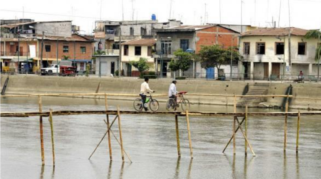
Foto 1: Puente peatonal sobre el río Daule
