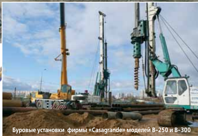
Устройство буронабивных свай на рамповой части тоннеля под Финским заливом
