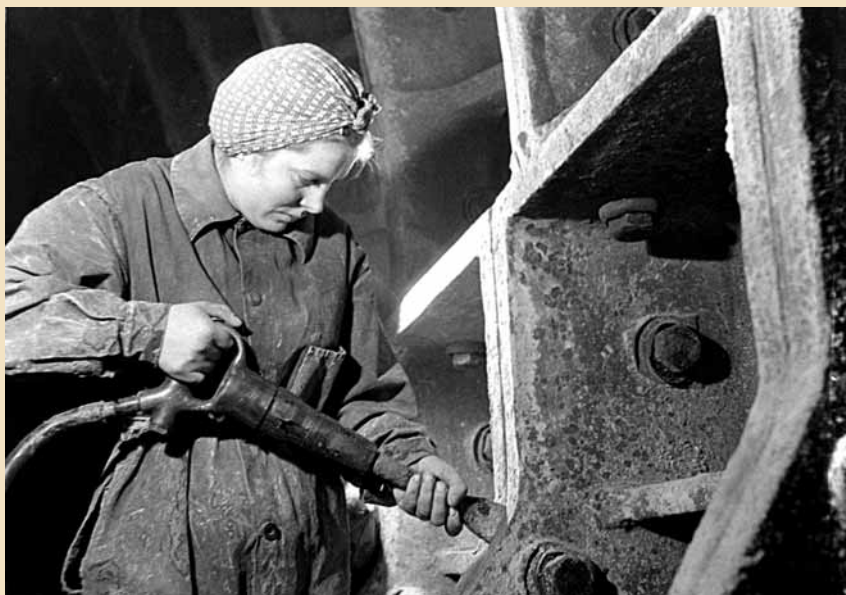
Стахановка Л. М. Никитина за работой на строительстве станции метро «Белорусская», 1950 г.
