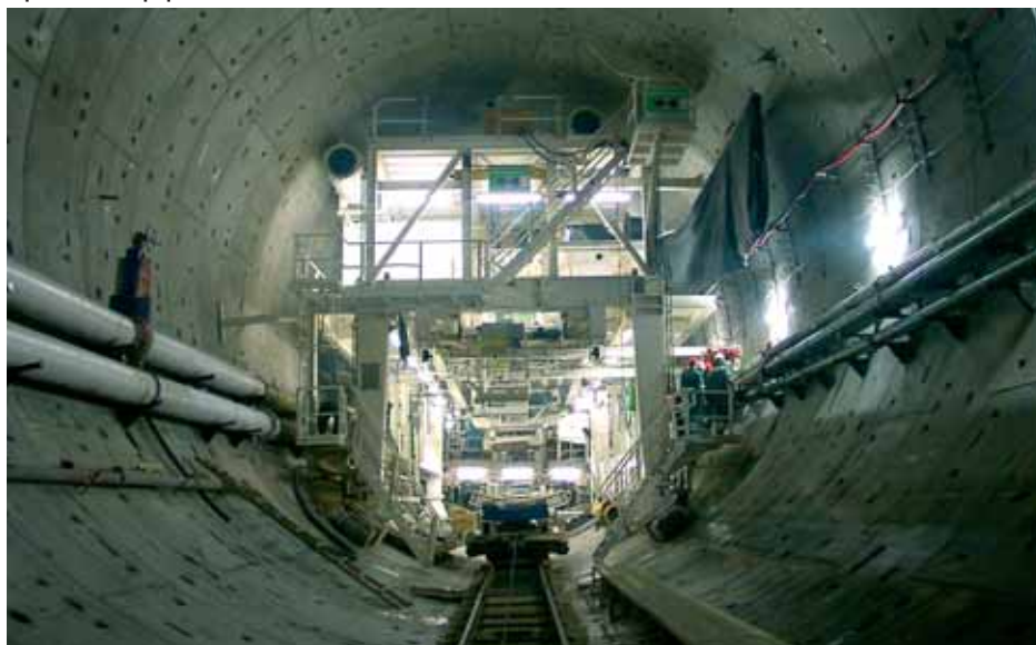
Проходка Лефортовского тоннеля
