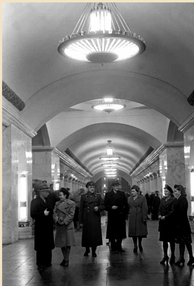
Подземный зал станции «Курская», 1950 г.
