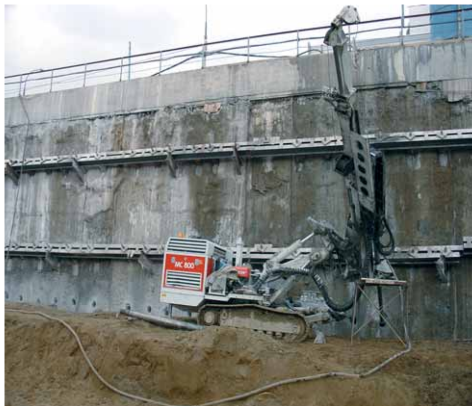
Буровой станок Cotacchio MC-80 для установки анкеров
