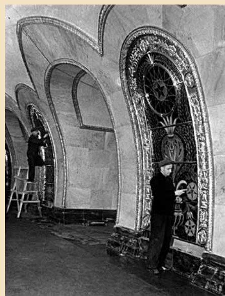
Станция «Новослободская». Отделка витражей, июль 1951 г.
