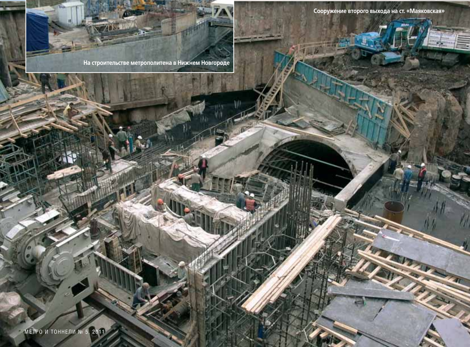
Начало проходки наклонного хода с помощью ТПК «Ловат» на ст. «Марьяна Роцца»
