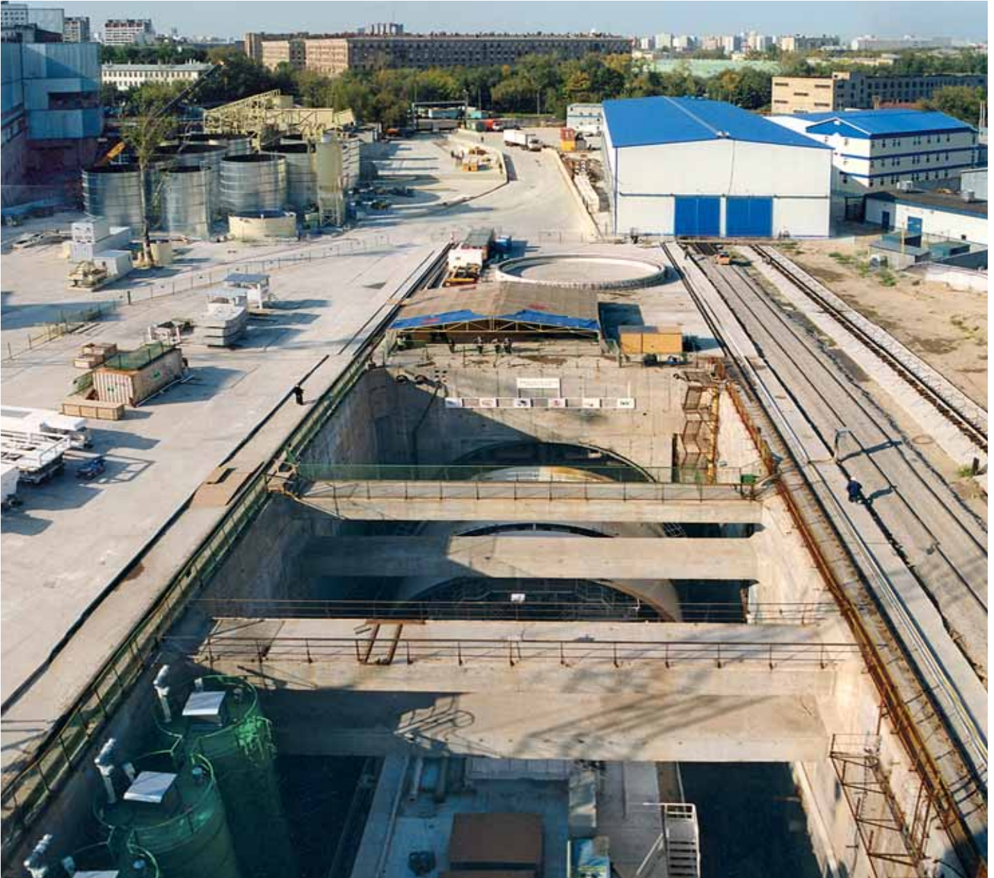
Панорама строительной площадки Лефортовского тоннеля
