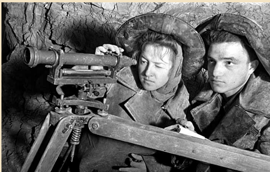
Маркшейдеры-комсомольцы О. Чакина и В. Цокота проверяют направление щитовой проходки тоннеля станции «Комсомольская», 1948 г.
