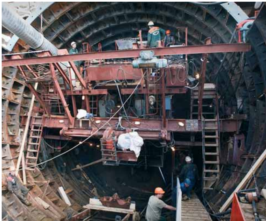
Сооружение наклонного хода на станции «Сретенский бульвар»
