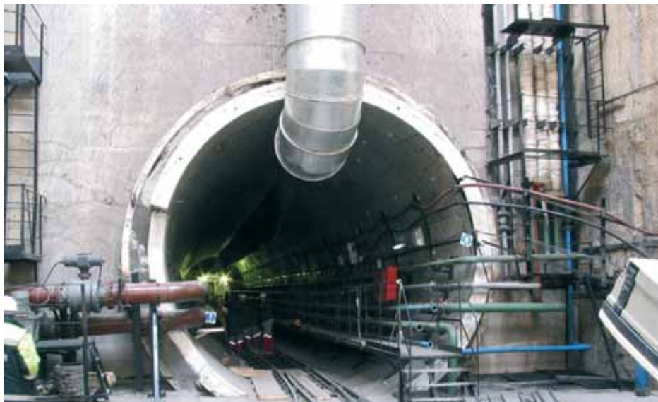
Проходка сервисного тоннеля в Серебряном Бору
