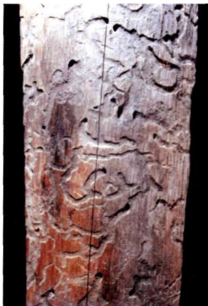
Рис. 76. Повреждение древесины личинкой ДРОВОСЕКА ХВОЙНОГО БЛЕСТЯЩЕГРУДОГО. Ориг.
