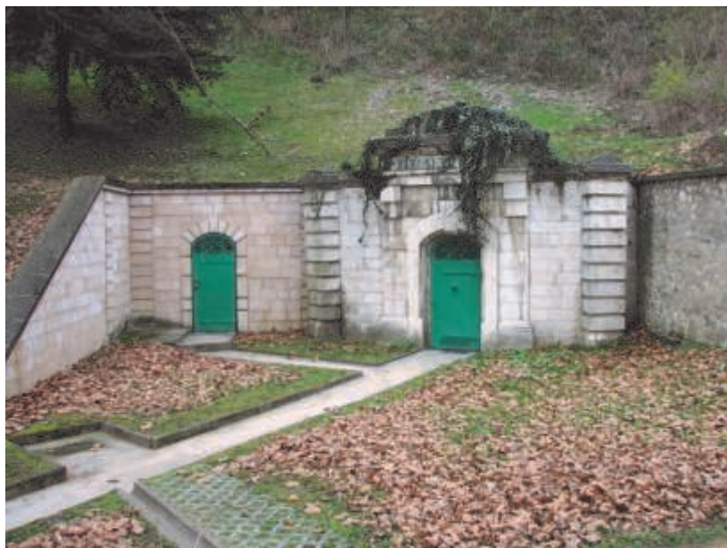
3. kép. A Tettye Vízmű.
