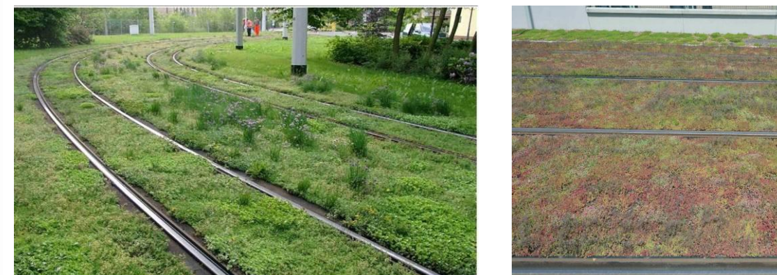
Figure 83 : Exemples de revêtements engazonnés de plateforme
