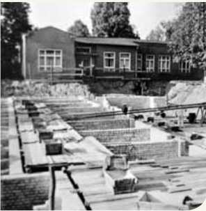
Baustelle der späteren HNO-Klinik
