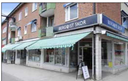
Banken 10, byggnad 1 (ovan och höger)
