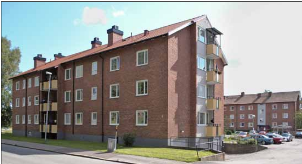
Vallen 32 (norra delen byggnad 2, norra delen byggnad 1)
