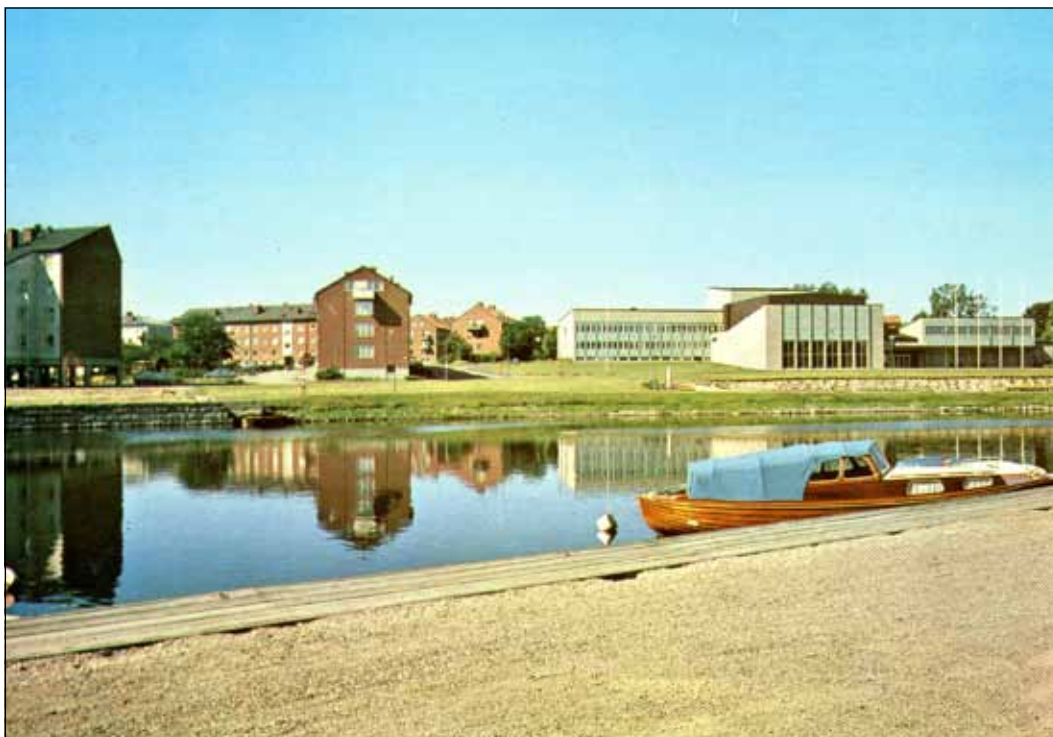
Till vänster i bild kvarteret Hamnen med flerbostadshus uppförda under tidigt 1960-tal. Till höger medborgarhuset, invigt 1965.
