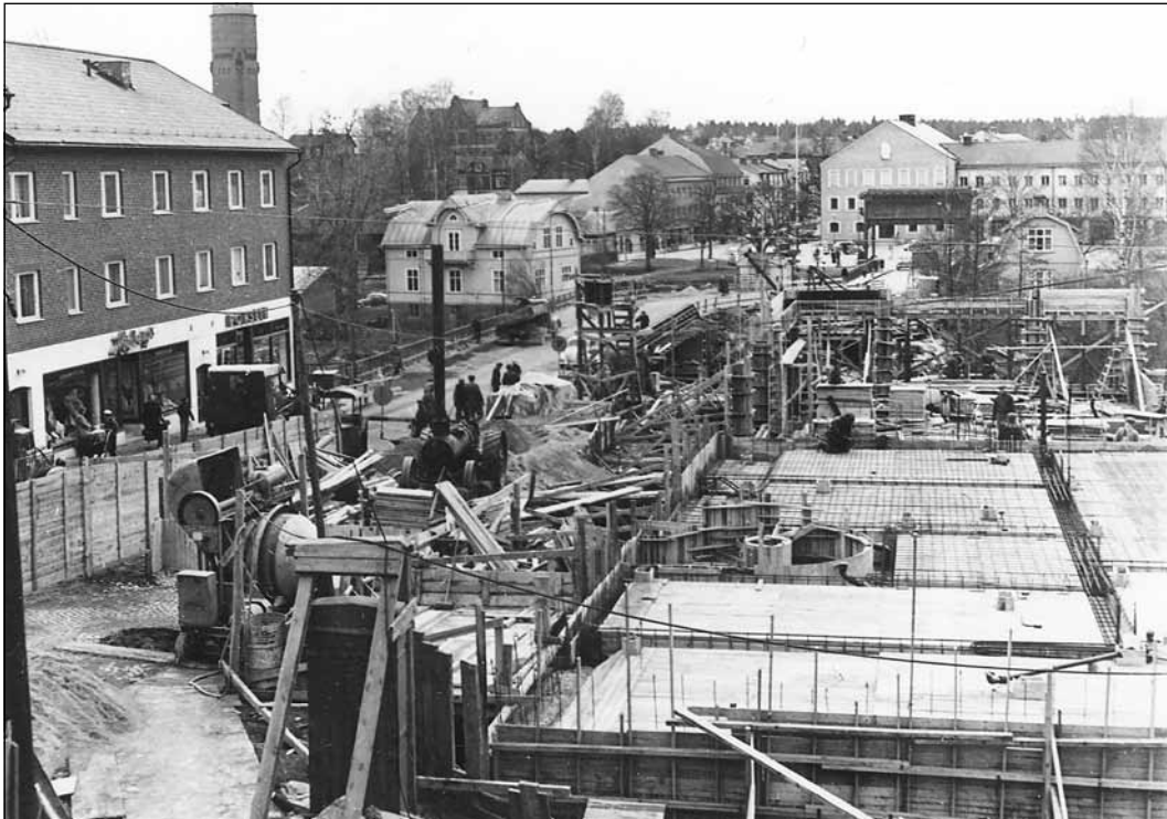
Uppförandet av fastigheten Strömmen 3, omkring 1959. Foto: Lars-Åke Widing.
