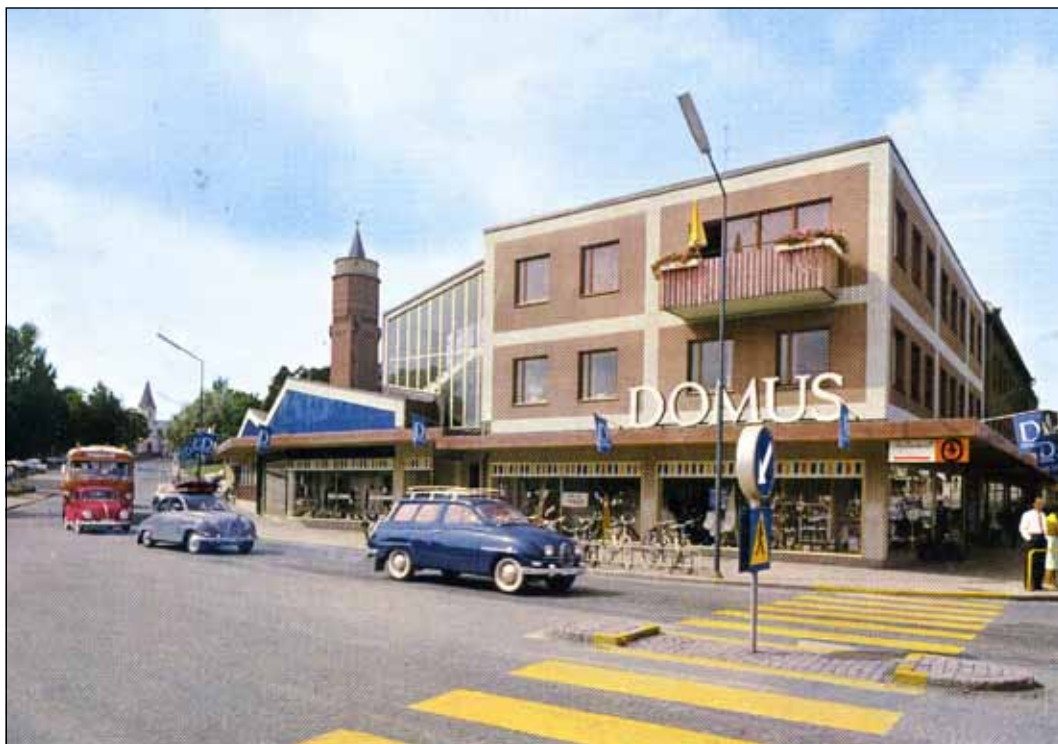
Domus vid hörnet Västra Storgatan-Kungsgatan, uppfört från mitten av 1950-talet fram till omkring 1960.
