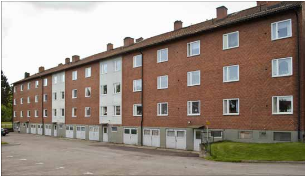
Vallen 32 (norra delen byggnad 2)
