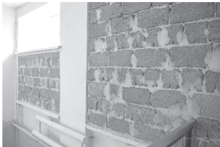
Из-за крыши новой формы пришлось заложить три окна. Теперь образовавшиеся стены нужно оштукатурить
