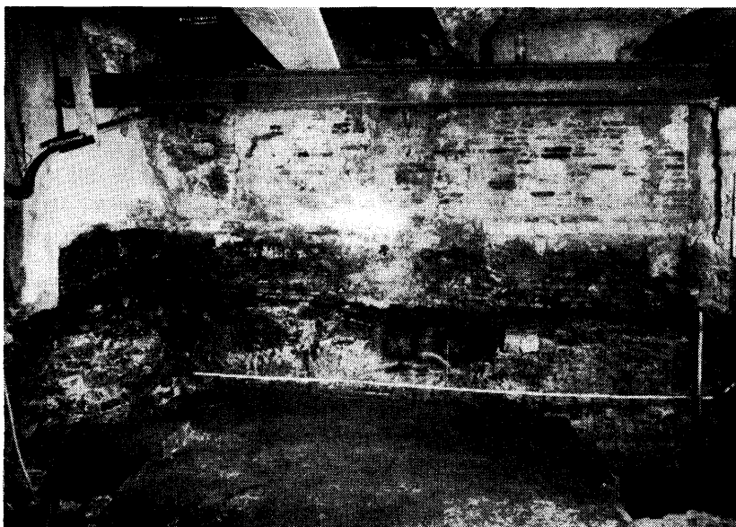
kelder van Nieuwendijk 125 met de ontgraven en ingemeten middeleeuwse fundering.
