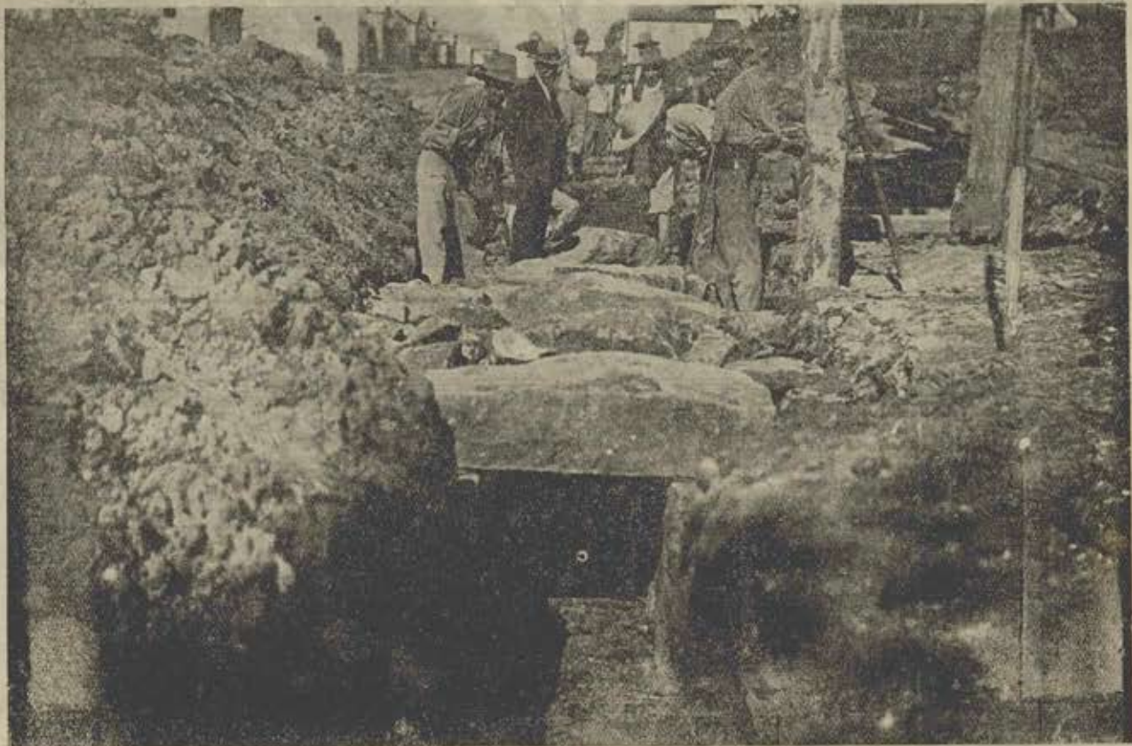
Construção de boeiro no cruzamento das ruas Venancio Aires e Colombo
