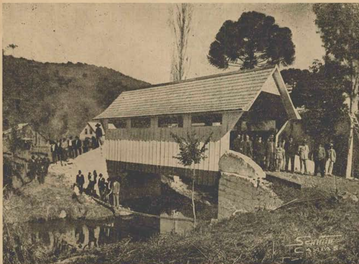
Reconstrução da ponte sobre o arroio Rio Branco
