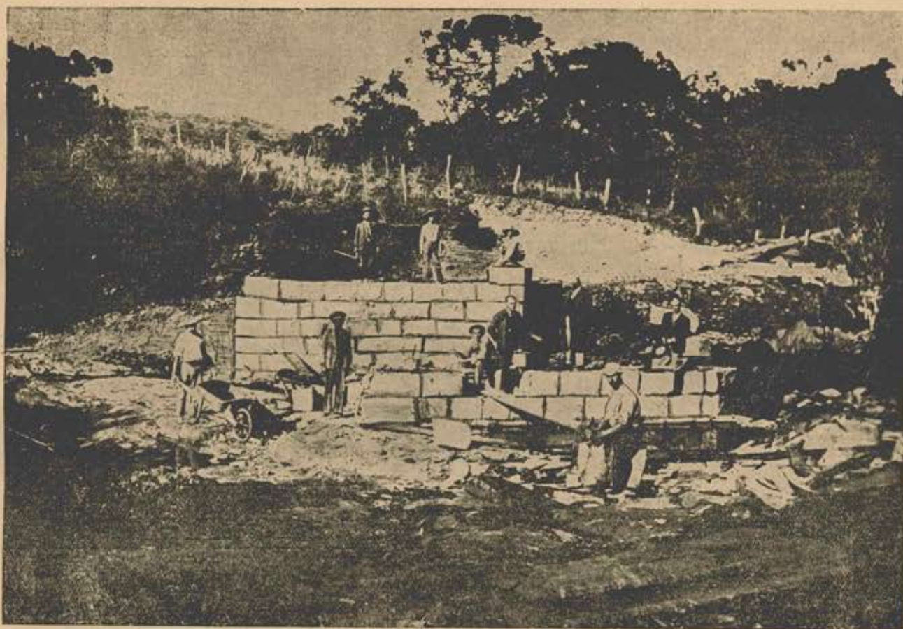
Construção da ponte sob e o arroio Ranchinho
