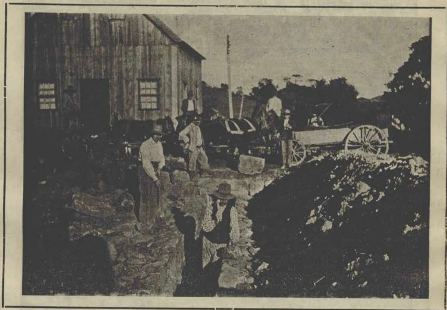
Construção de um boeiro á rua Venancio Aires
