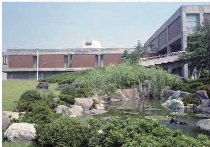
移転当時の外観。当時は県立美術館設立前で、エントランス付近には大きな池があった。
