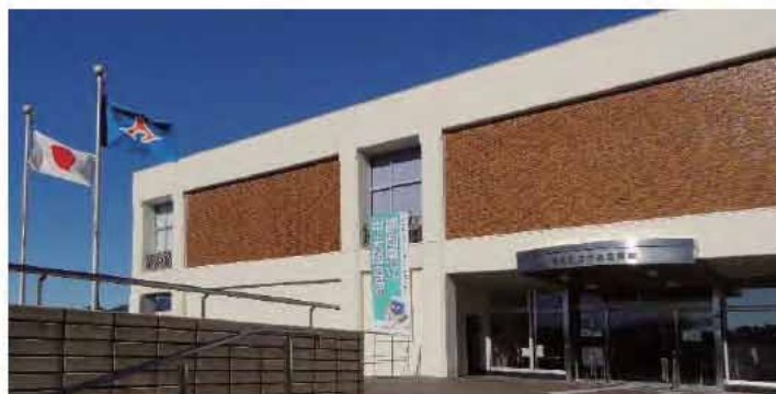
エントランス付近の外観(平成 28(2016)年 1 月現在)
