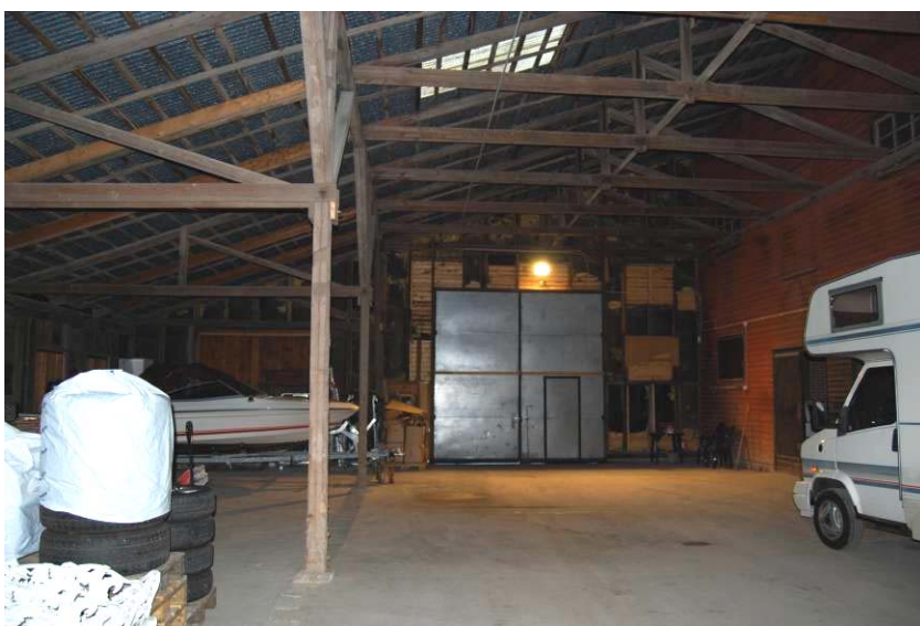
Interiör från tillbyggnad på torkladans östra fasad.
