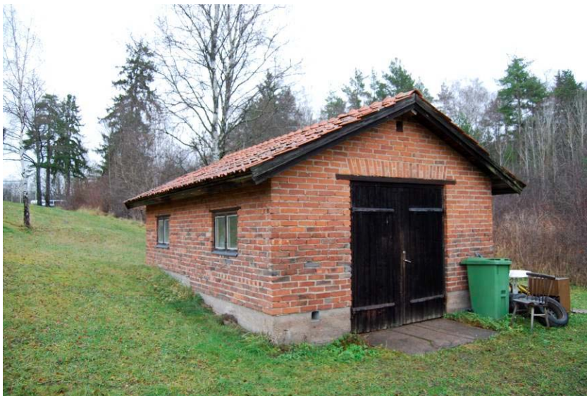
Lokstallet Rälsen skymtar i betongläggningen utanför porten. 20081209sb-46
