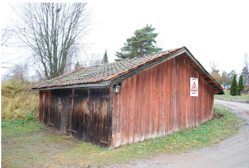
Smedjans södra och östra fasader. 20081209sb-45
