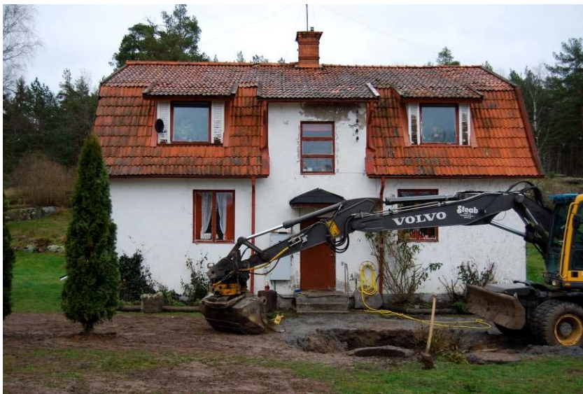
Västra fasaden 20081209sb-30
