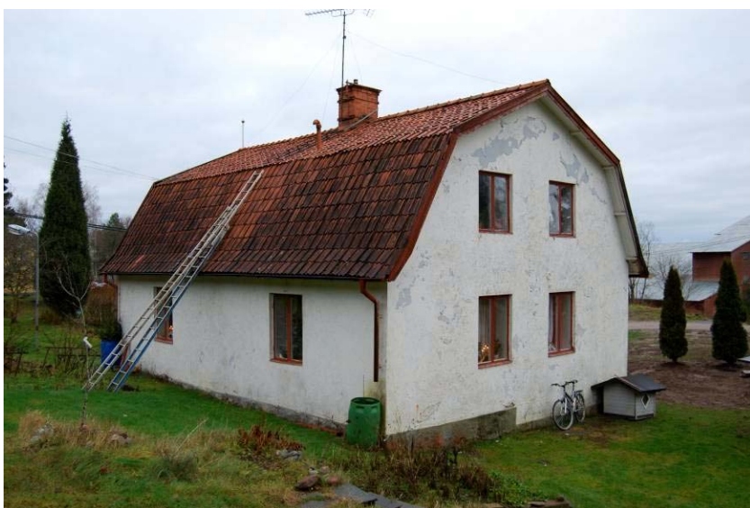
Norra och östra fasaderna. 20081209sb-29
