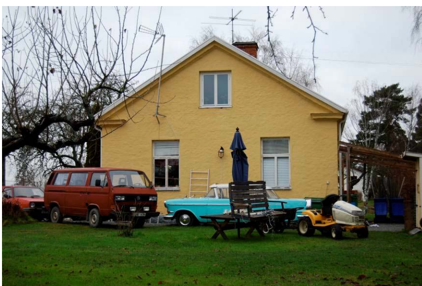
Tegelmästarbostadens södra gavel. 20081209sb-42
