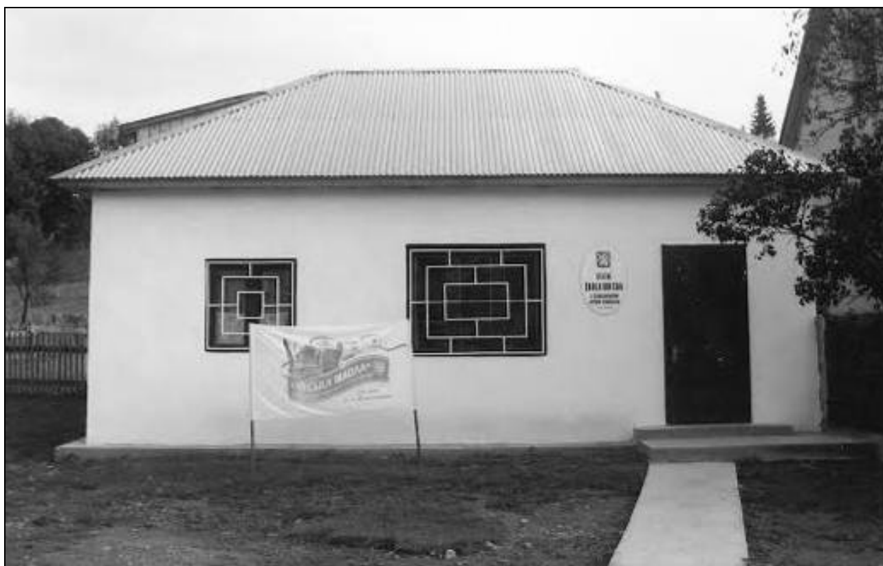
Budova muzejní Obecné školy v Koločavě
