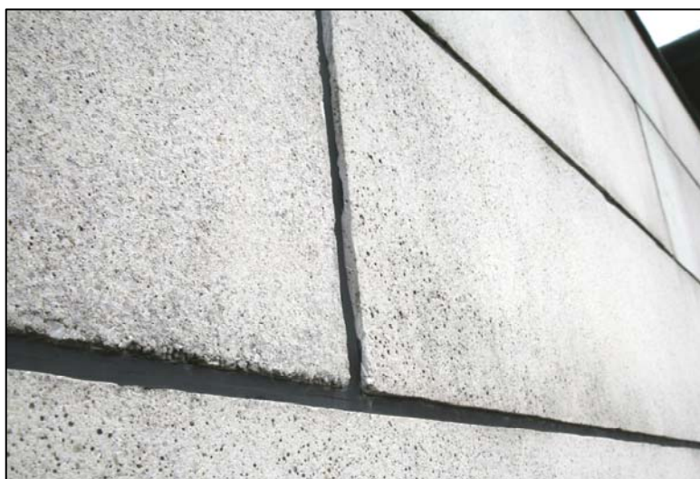
Betongskivor med frilagd finkrossad marmor och svart mjukfog. På klockstapeln är fogen vit. Kvastekulla kapell 1963.
