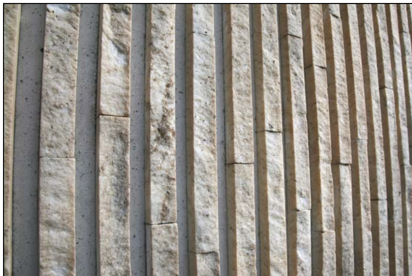
Smala vertikala travertinstavar i vitbetong Sankt Jörgens kapell 1969.
