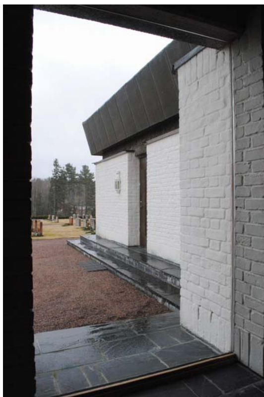
Fri sikt i Dalstorps kyrka där fönstren markeras minimalt och gränsen mellan ute-inne blir diffus genom att golv-materialet fortsätter på utsidan.
