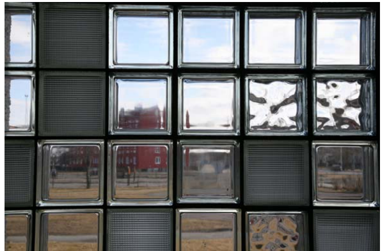
Olika betongglastyper förvränger utblickarna från de stora fönsterpartierna i Tolereds kyrka.
