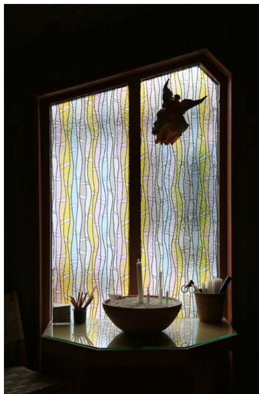
Bemålat råglas i milda pastellfärger utgör insynsskydd i fönstret åt gatan i Stenkullens kyrka.
