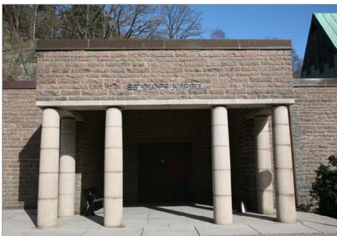
Byggnadens kolonnförsedda entré.
