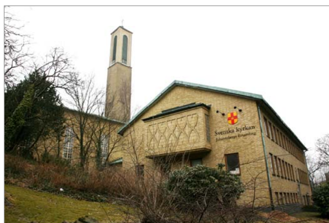
Johannebergs kyrka är byggd i suterräng utmed berget .
