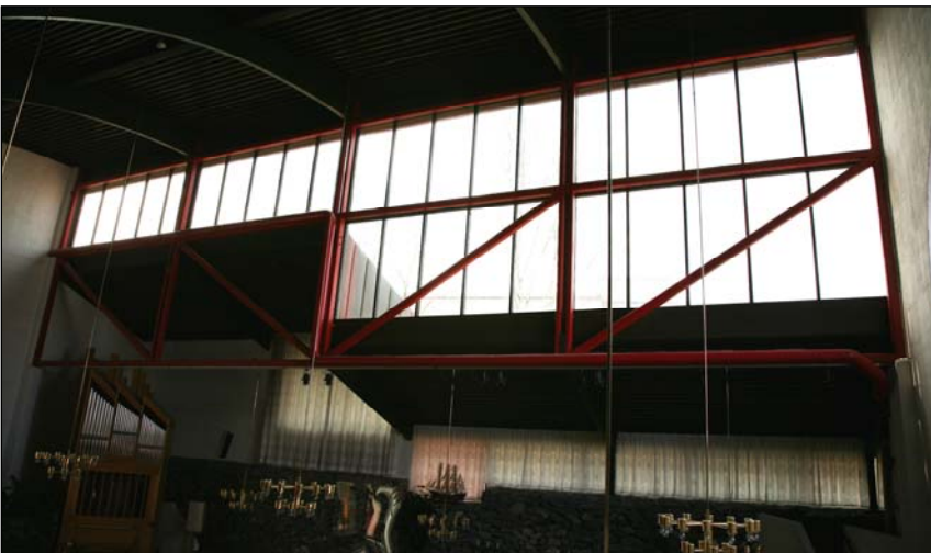
Glöstorpskyrkans stora fönsterparti med sina signifikativa röda stag. De nedre fönstren döljs av gardiner.
