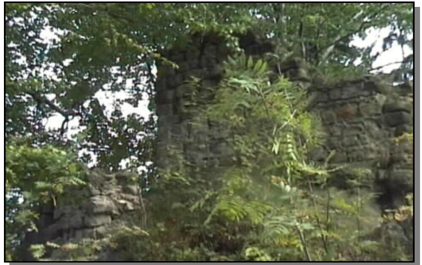
Ehemaliger Turm (Stark verwachsen)
